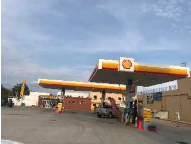
Aspecto del interior de la estación
