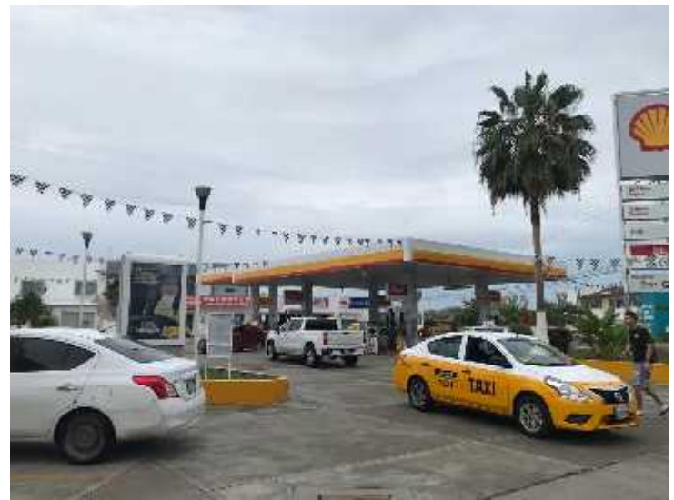
Aspecto general de la estación.
