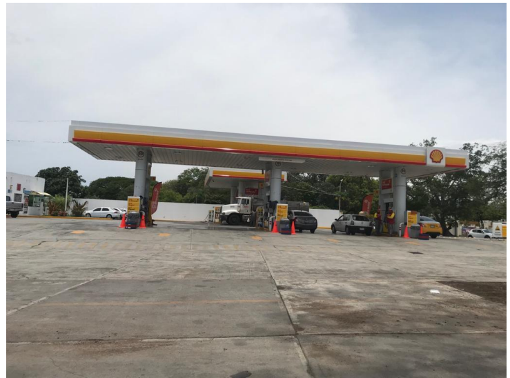
Aspecto general de la estación.
