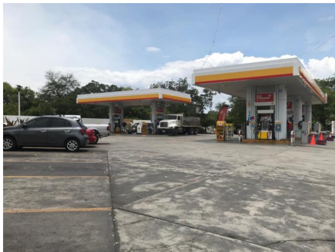
Aspecto del interior de la estación
