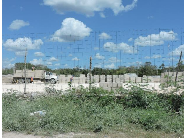
A4.-Vista hacia el noreste, se observa las instalaciones de Proveedor de materiales de construcción Trivasa.
