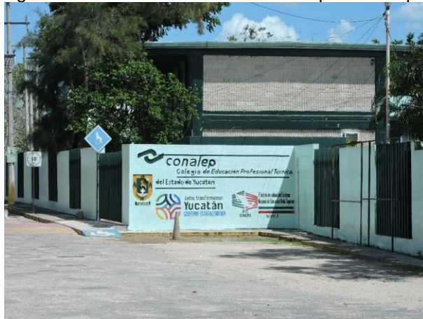
E11.-Vista hacia el este, se observa el plantel del Colegio de Educación Profesional Técnica CONALEP.
