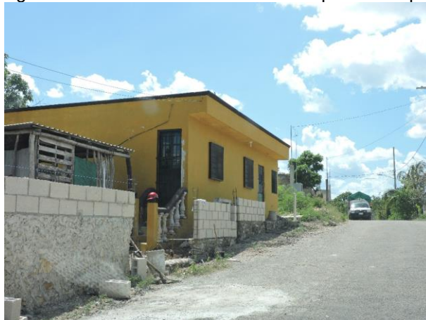
B5.-Vista hacia el este, se observa casas habitación y la calle 35 A del fraccionamiento Santa Cruz.
