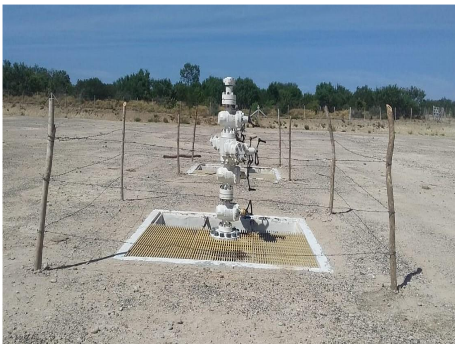
Fotografía I.1.5-16.- Localización construida para el Pozo Santa Anita 290.
