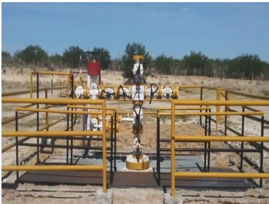
Fotografía I.1.5-11.- Localización construida para el Pozo Santa Anita 325.
