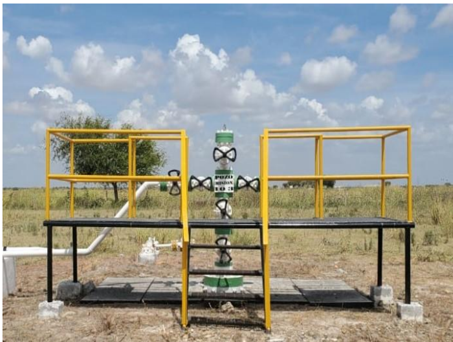
Fotografía I.1.5-5.- Localización construida para el Pozo Misión 103.
