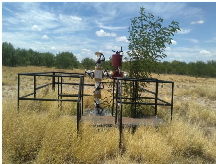
Fotografía I.1.5-3.- Localización construida para el Pozo Géminis 1162.
