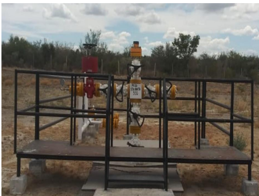
Fotografía I.1.5-8.- Localización construida para el Pozo Santa Anita 310.
