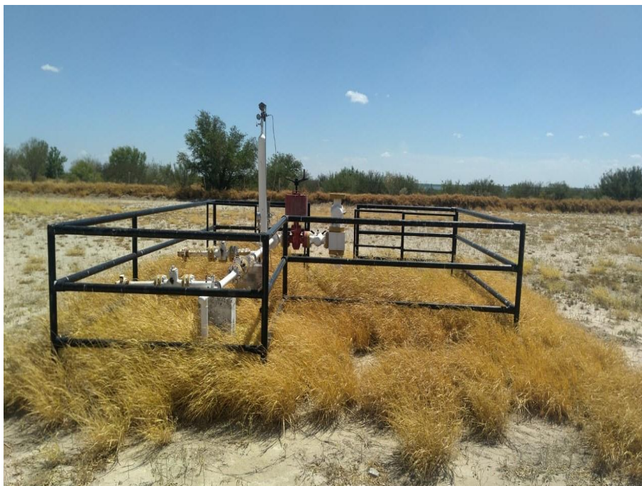
Fotografía I.1.5-1.- Localización construida para el pozo Géminis 103.
