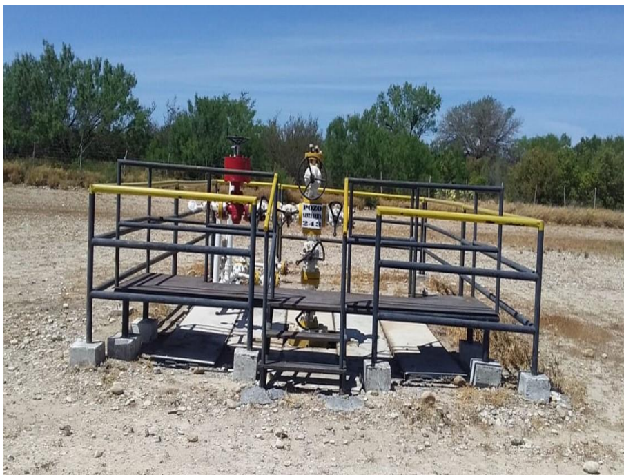
Fotografía I.1.5-7- Localización construida para el Pozo Santa Anita 243.
