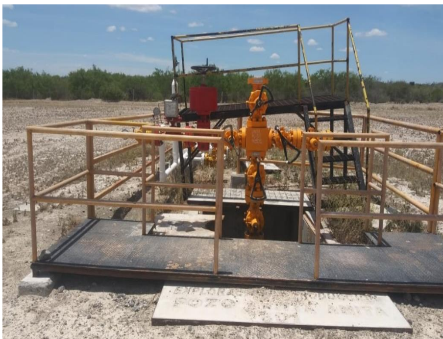
Fotografía I.1.5-12.- Localización construida para el Pozo Santa Anita 601.
