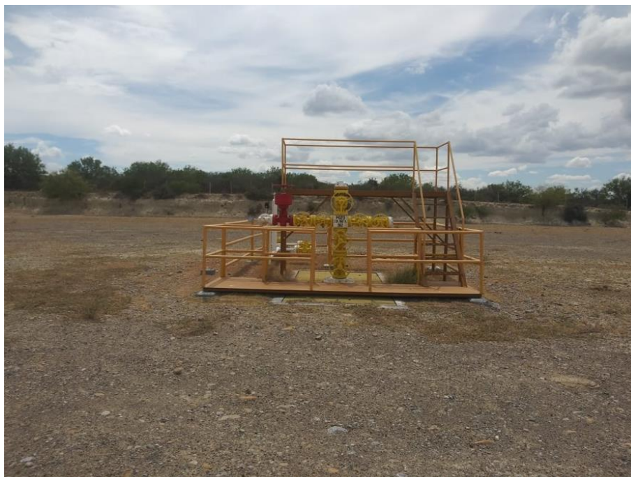
Fotografía I.1.5-9.- Localización construida para el Pozo Santa Anita 312.
