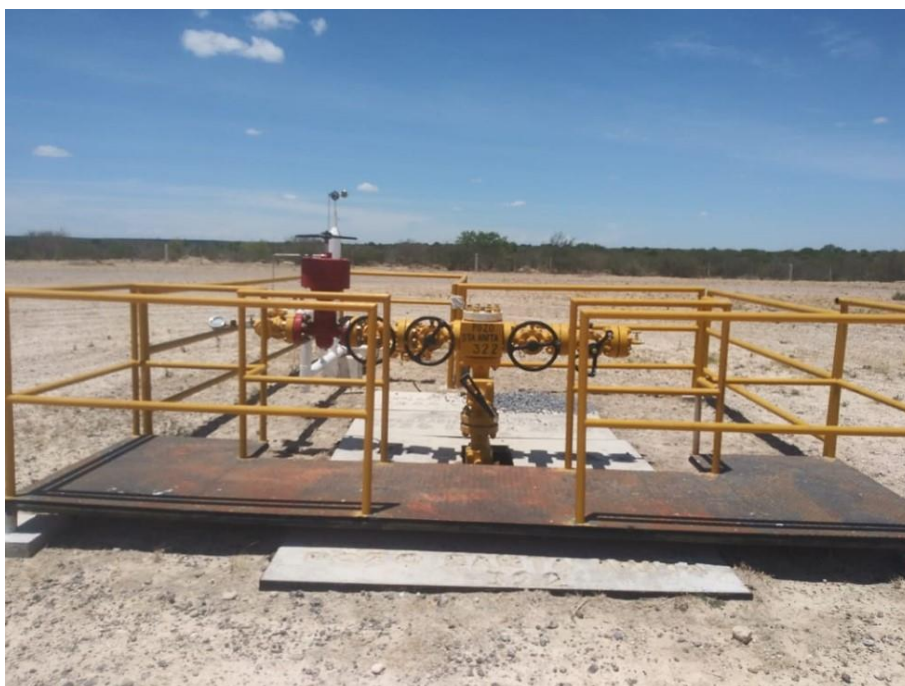
Fotografía I.1.5-10.- Localización construida para el Pozo Santa Anita 322.
