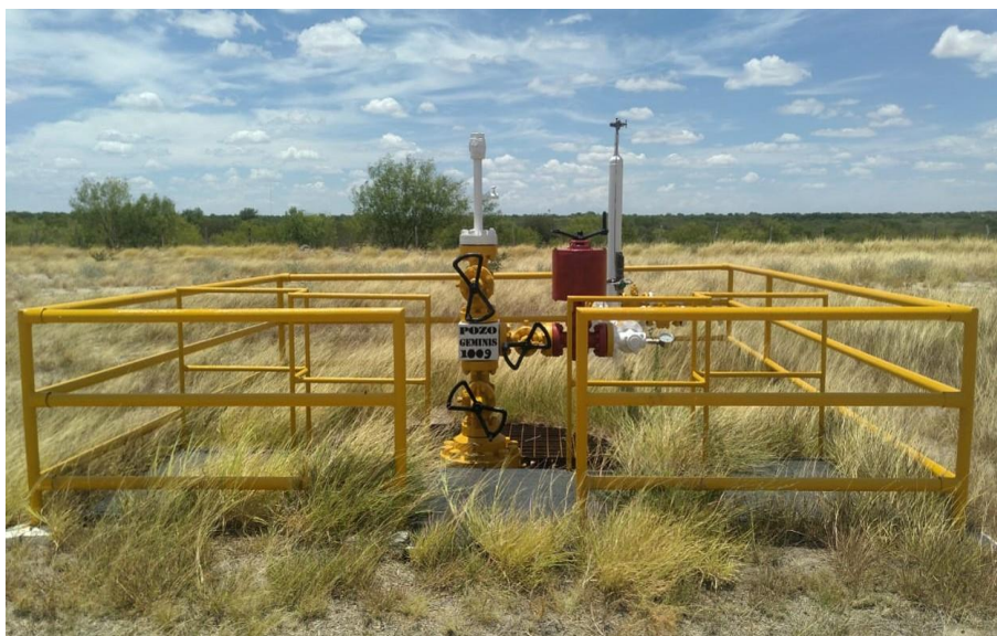
Fotografía I.1.5-4.- Localización construida para el Pozo Géminis 1170.
