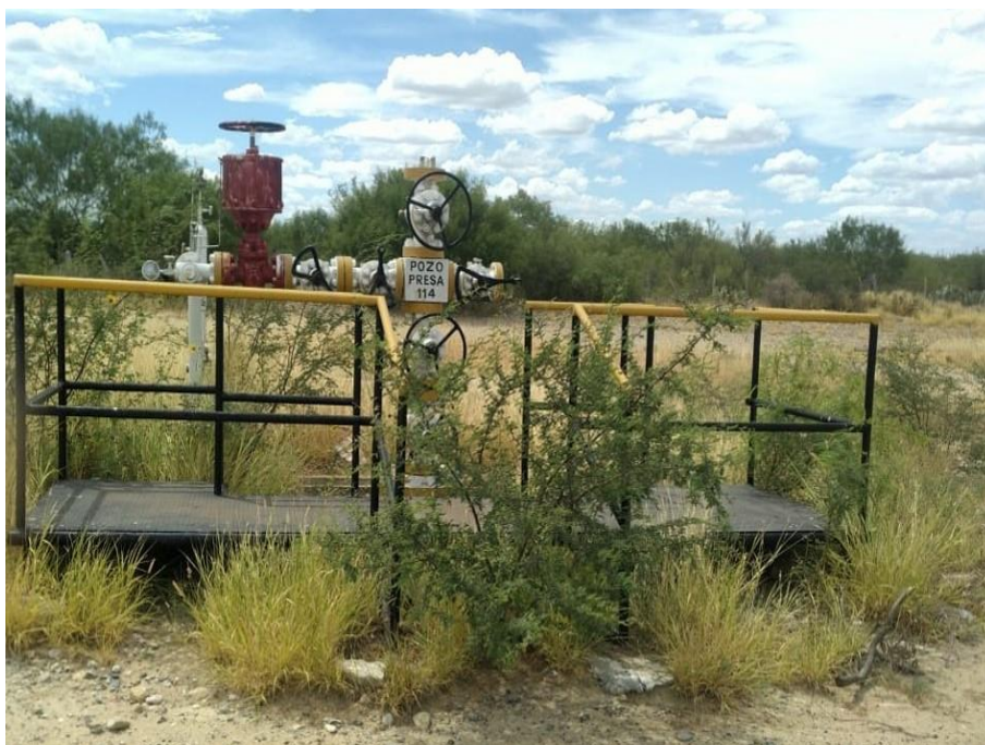
Fotografía I.1.5-6.- Localización construida para el Pozo Presa 114.
