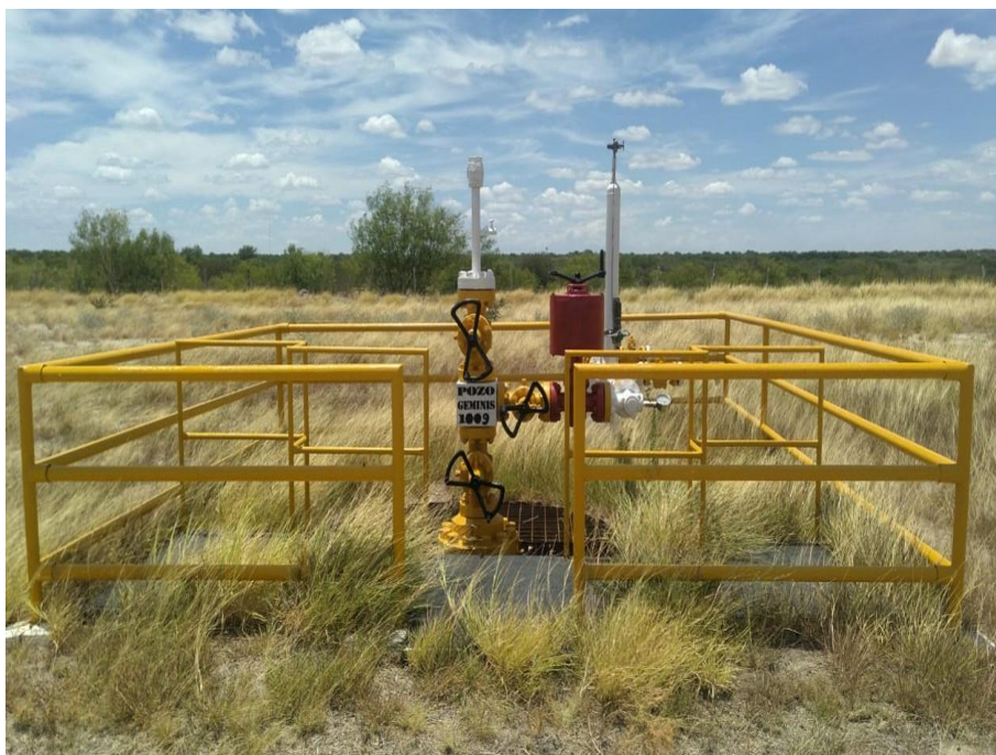
Fotografía I.1.5-2.- Localización construida para el pozo Géminis 1009.
