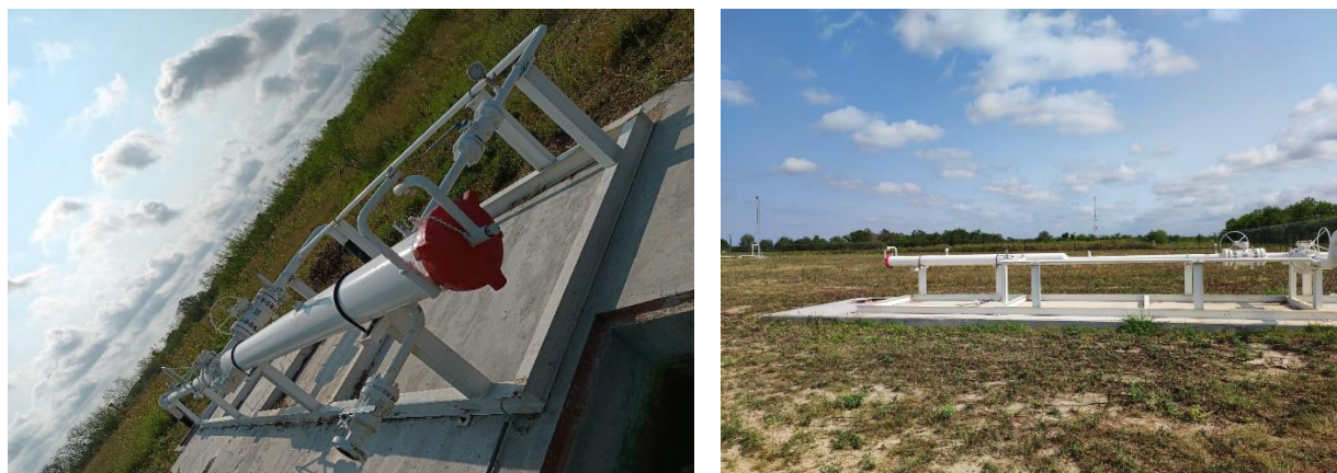
Figura 2.21 Estado actual de la trampa de envío y recibo
