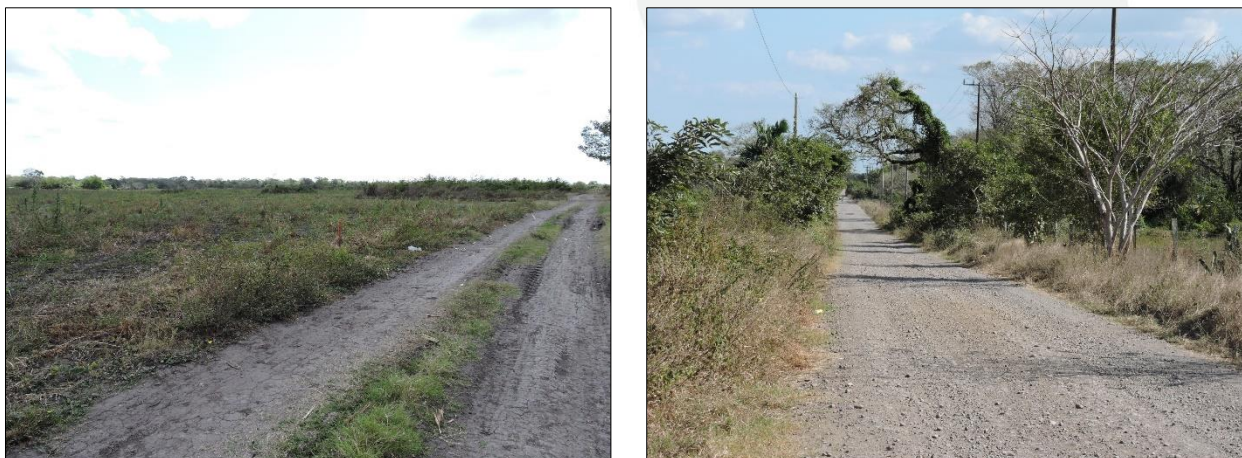
Figura IV-55. Condiciones áreas de potrero y agrícolas en el SA y AP
