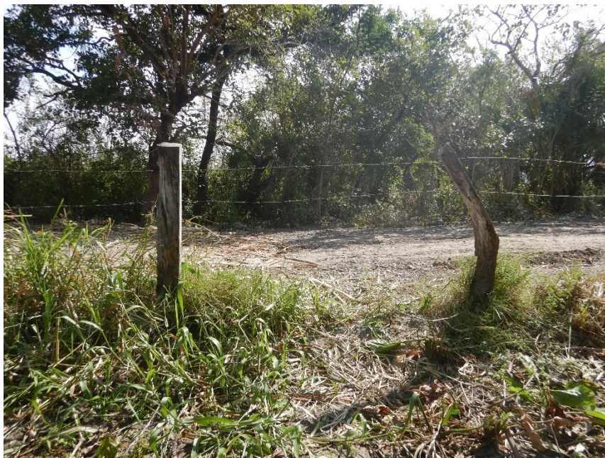
Figura II-18. Vista del escurrimiento margen izquierdo donde será construido el puente vehicular
