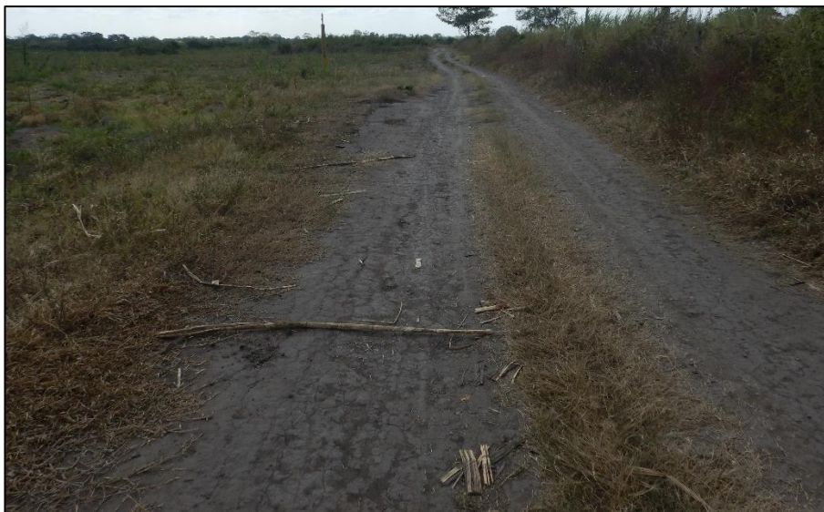
Figura II-22. Vista del camino de terracería que conduce hasta el cruce del escurrimiento
