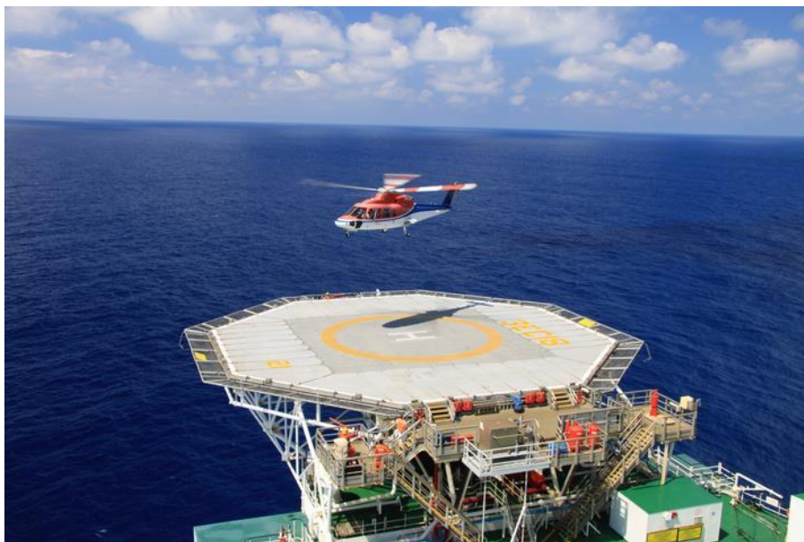
Imagen 2-4. Helipuerto costa afuera.
