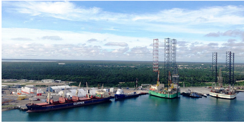
Figura 2.2. Puerto de Dos Bocas.
