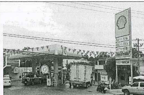
Imagen de Street View™, de enero de 2022 donde se aprecia el PROYECTO con cambio de imagen en techado, dispensarios y tablero de precios.
