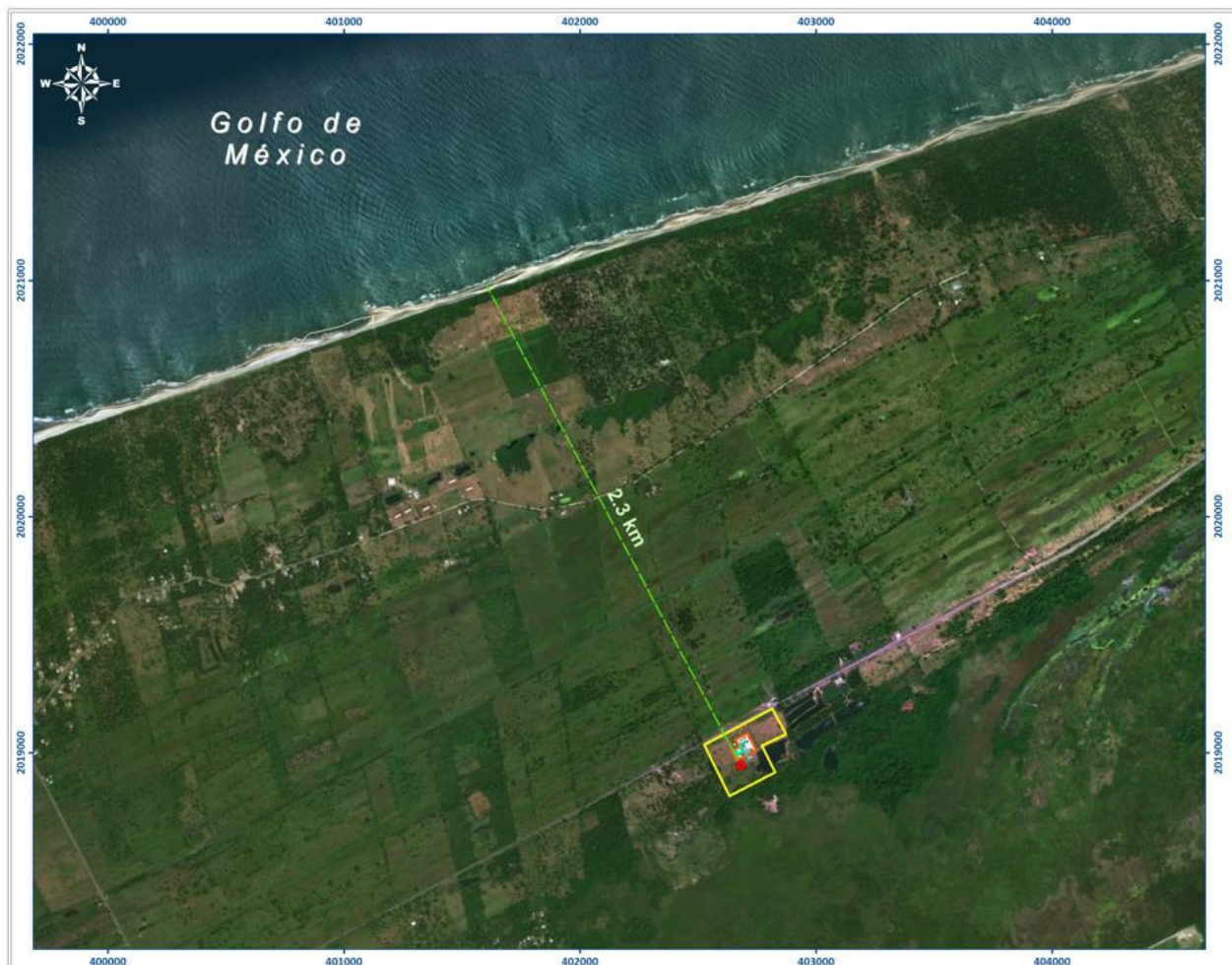
Figura 5 – Instalación Receptora en Tierra (ORF)
