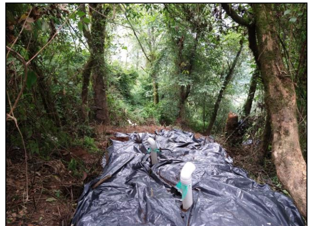
06. Vista del área afectada cubierta con película de polietileno de alta densidad.
