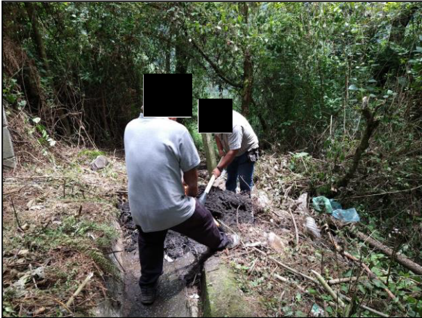
01. El sitio fue debidamente acondicionado para realizar la barrera de contención, a fin de evitar el desplazamiento horizontal del hidrocarburo.
