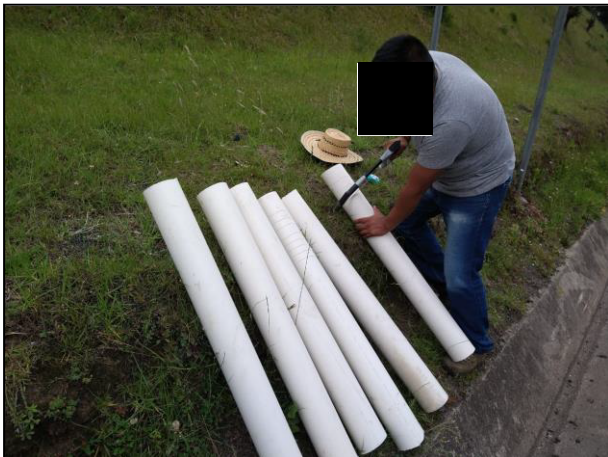
03. Se acondiciono la tubería para los filtros de carbón activado.
