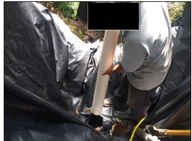
04. Se colocaron tubos de carbón activado en el área afectada.
