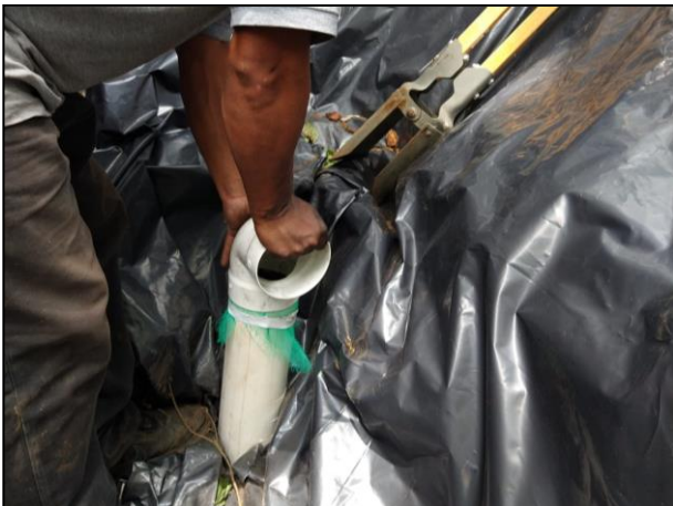
05. Colocación de tubos con filtro de carbón activado.
