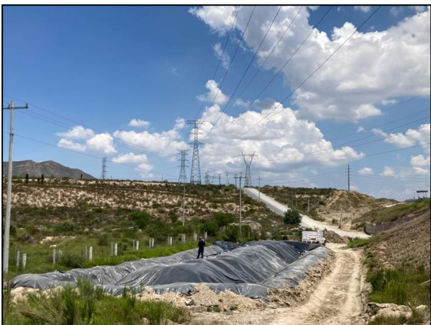
41. Vista general de la celda provisional.
