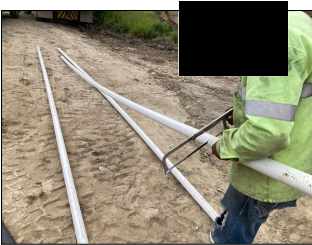
37. Con apoyo de recurso humano se llevó a cabo la preparación de tubería ranurada de PVC, la cual conformará el sistema de aireación para la Biopila.
