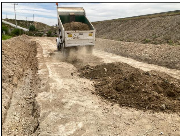
11. Se colocó una capa de arcilla sobre la base de la celda provisional.
