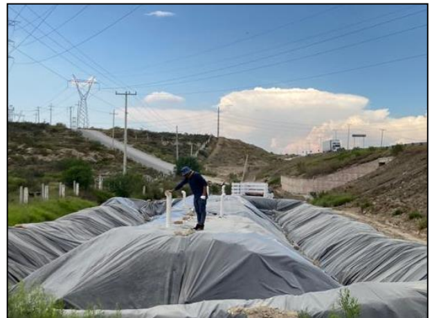
42. Con apoyo de recurso humano se realizó la instalación de filtros de carbón activado dentro de la celda provisional.
