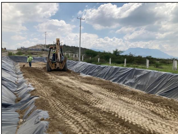
17. La segunda capa de arcilla fue esparcida con apoyo de retroexcavadora.
