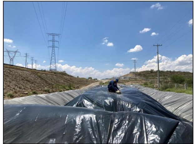
40. La celda provisional fue cubierta en su totalidad con membrana de polietileno de alta densidad.
