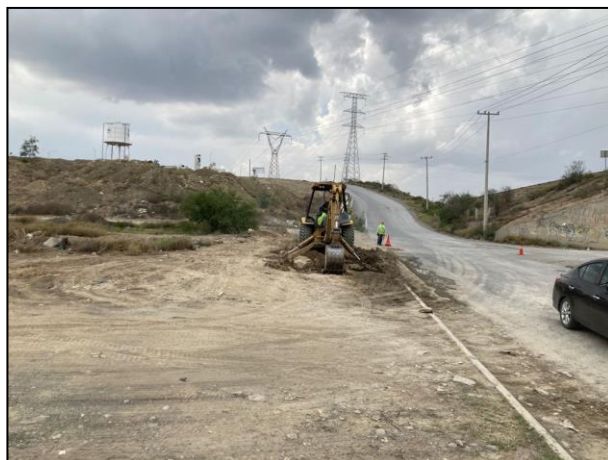
29. Previo a las actividades de extracción y manejo del material contaminado este fue humedecido a fin de evitar la emisión de gases a la atmósfera.
