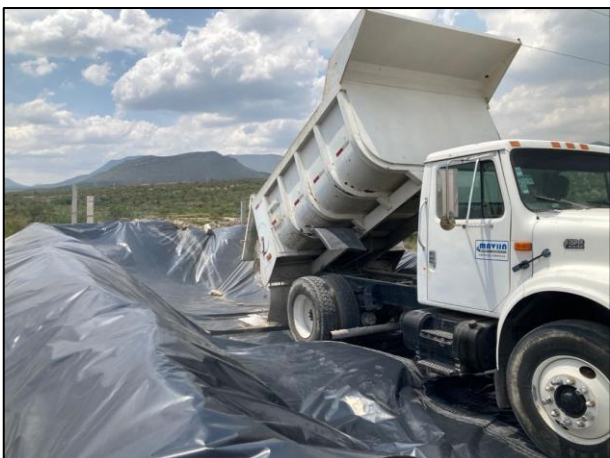
11. Depósito del material contaminado (basura y escombros) dentro de la celda temporal.
