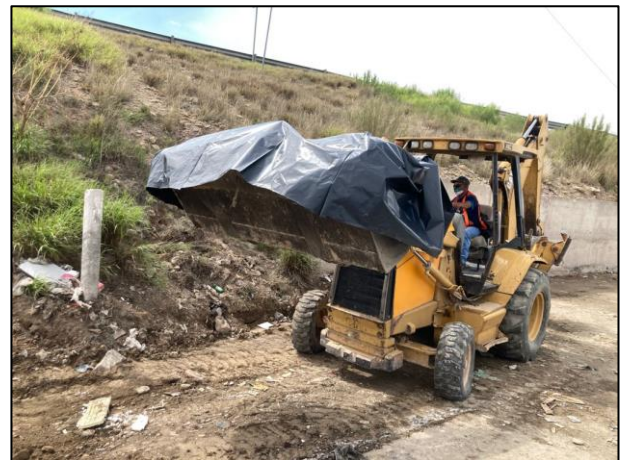
08. Acarreo del material contaminado (basura y escombros) hacia camión de volteo.
