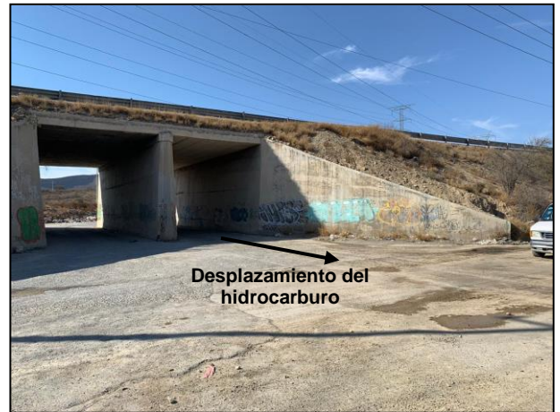
14. Posteriormente el hidrocarburo continuó su desplazamiento pasando a través de un paso a desnivel (Salida)
