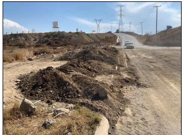
16. Material colocado por los cuerpos de auxilio el día del accidente a fin de contener el desplazamiento del hidrocarburo.
