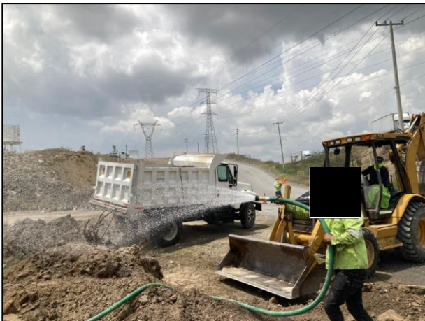
27. Se humedeció el material edáfico de la zona que fue colocado sobre el área de la Fosa de Excavación “B” por los cuerpos de auxilio el día del accidente y se acarrió hacia la celda provisional.
