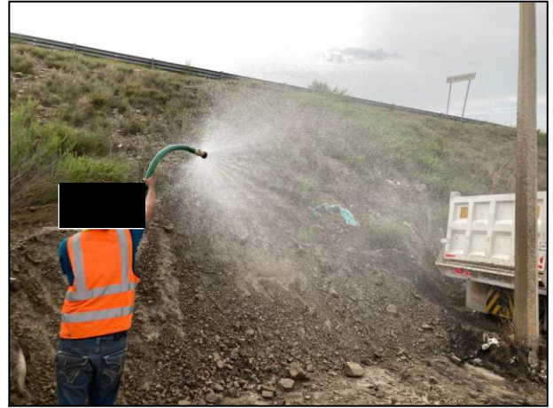
20. Durante las actividades de extracción y manejo del material contaminado este fue humedecido a fin de evitar la emisión de gases a la atmosfera.
