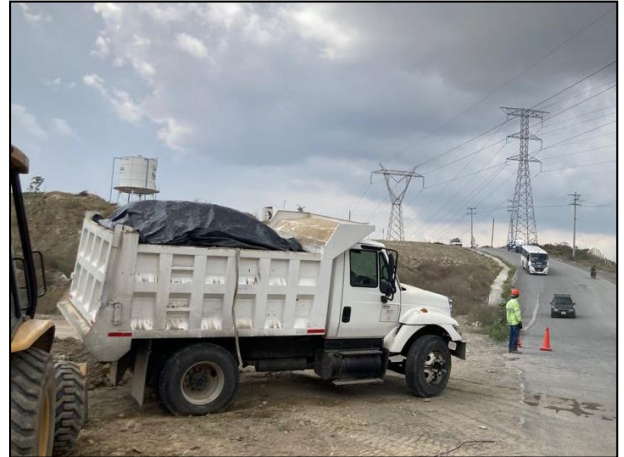
34. Actividad de acarreo del material contaminado hacia la celda provisional.
