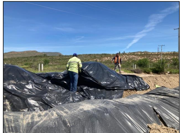
36. El material edáfico contaminado se cubrió en todo momento a fin de evitar la emisión de gases a la atmosfera.
