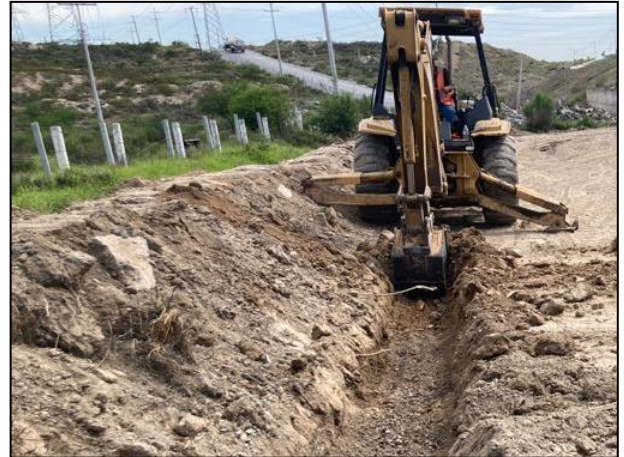
08. Con apoyo de retroexcavadora se construyeron las canaletas perimetrales para la captación de lixiviados.
