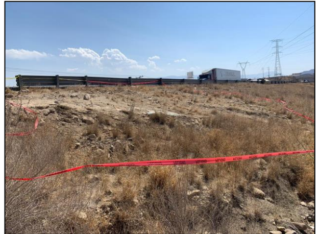
02. Se realizó la debida señalización del sitio dañado.
