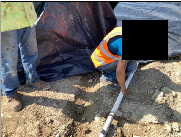
39. Con apoyo de recurso humano se llevó a cabo la instalación de la tubería en la celda provisional.
