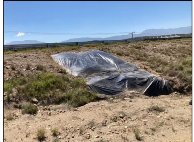
02. Con apoyo de recurso humano se tendió una película de polietileno de alta densidad sobre el Área Afectada.
