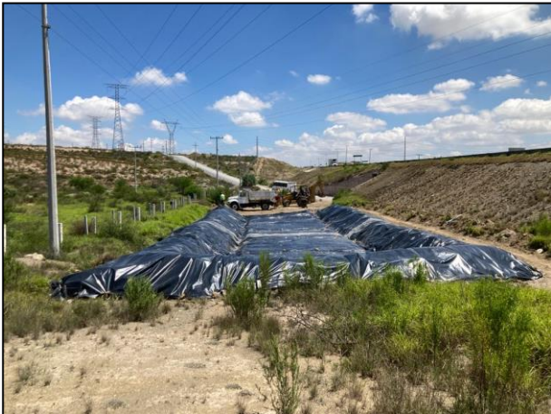
15. La celda provisional se cubrió en su totalidad con una membrana de polietileno de alta densidad.
