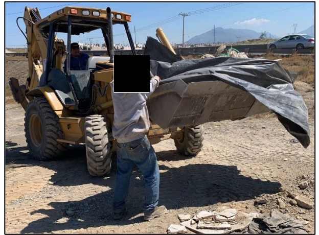
16. El material contaminado (basura y escombros) fue cubierto con membrana de polietileno de alta densidad.
