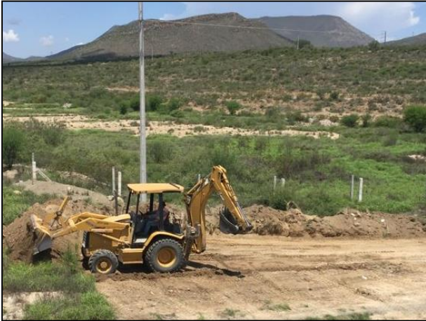
07. Con ayuda de maquinaria pesada como lo es la retroexcavadora, se realizó el acondicionamiento y nivelación del terreno designado para la construcción de la celda provisional.
