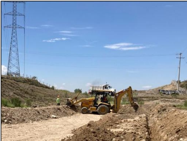
09. Construcción de los bordos perimetrales de la celda provisional.
