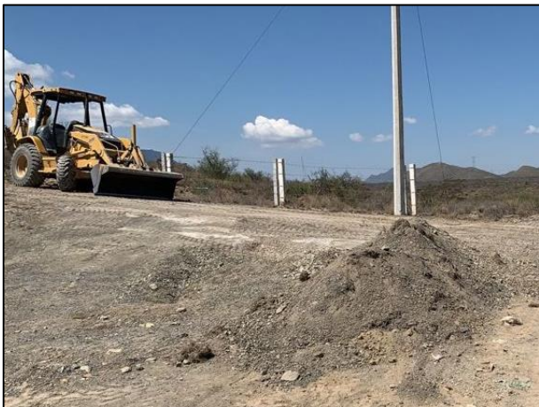
21. Con apoyo de retroexcavadora se llevó a cabo el desmantelamiento de los bordos perimetrales de la celda temporal.
