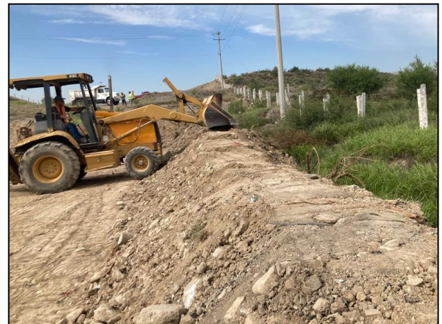
10. Compactación de los bordos perimetrales de la celda provisional.
