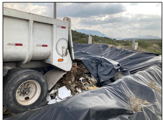
12. El acarreo del material contaminado (basura y escombros) se llevó a cabo con apoyo de camión de volteo.
