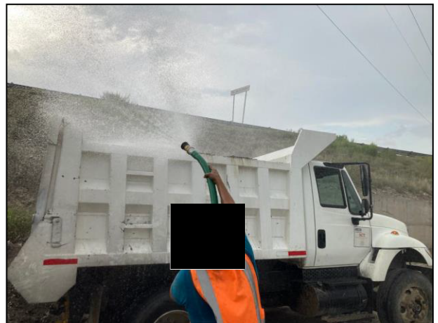
24. El material contaminado fue humedecido constantemente a fin de evitar su dispersión y emisión de gases a la atmosfera.
