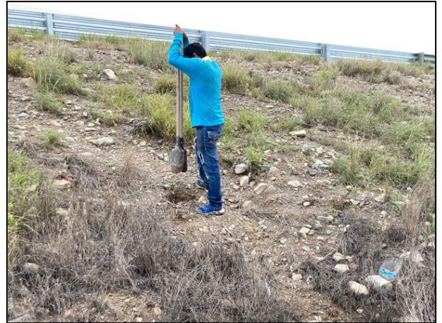
20. Se realizaron sondeos en el sitio dañado con apoyo de pocera (Área Afectada).
