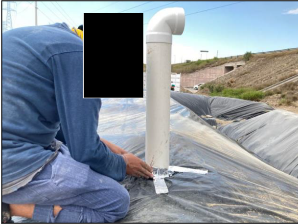
43. Se realizó el sellado de la membrana polietileno de alta densidad con cinta metálica.
