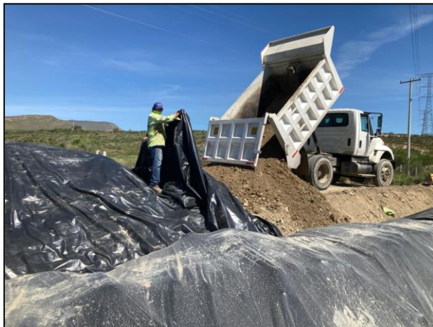
35. El material edáfico contaminado fue colocado en la celda provisional.
