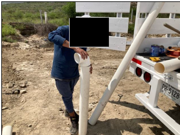
03. Se realizó el corte y preparación de los filtros de carbón activado, para su posterior colocación en el Área Afectada.
