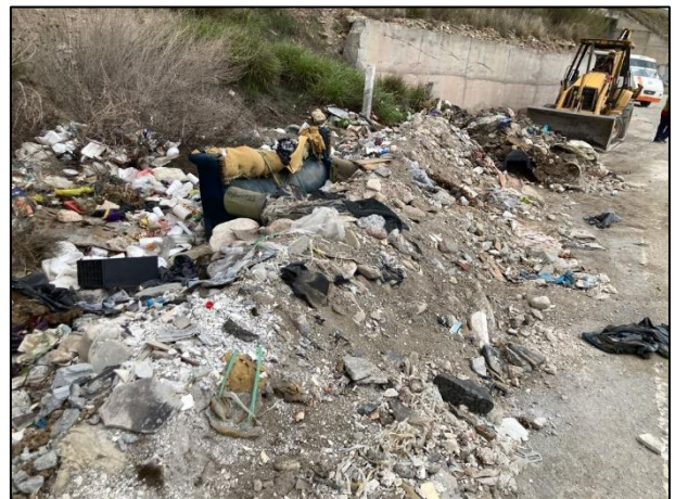
06. Con apoyo de retroexcavadora se realizó la recolección del material contaminado (basura y escombros).
