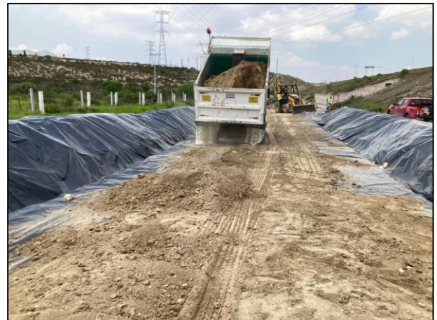
16. Se realizó la colocación de una segunda capa de arcilla sobre la base de la celda provisional, y se extendió dicha capa de arcilla con ayuda de retroexcavadora.
