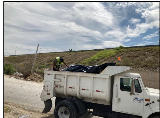
10. La basura y escombros depositados en el camión de volteo fueron cubiertos con membrana de polietileno de alta densidad.
