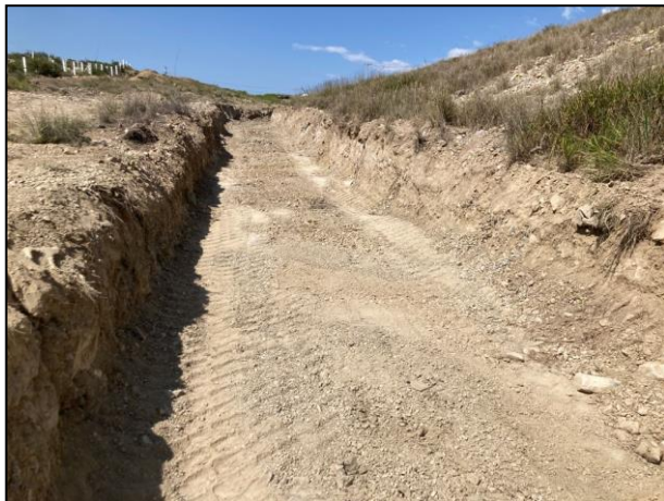
45. Vista general de la Fosa de Excavación “A”.
