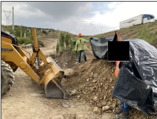
21. Durante la extracción y el manejo del material contaminado este permaneció cubierto con membrana de polietileno de alta densidad para así impedir la transferencia de hidrocarburos volátiles al ambiente.
