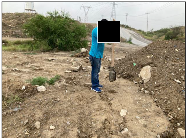
22. Se realizaron sondeos en el sitio afectado con apoyo de pocera (Fosa de Excavación "B").
