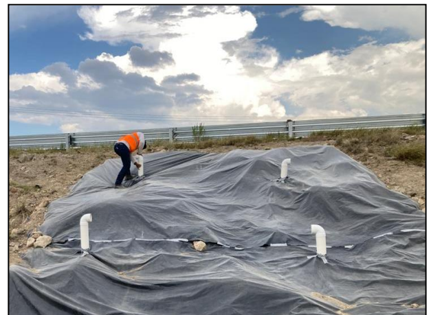
04. Colocación de filtros de carbón activado dentro del Área Afectada.
