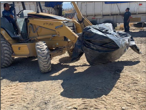
17. Se cubrió el material contaminado (basura y escombros) durante el traslado hacia la unidad de transporte autorizada.
