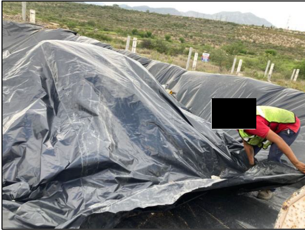
13. El material contaminado (basura y escombros) se cubrió en todo momento a fin de evitar la emisión de gases a la atmosfera.
