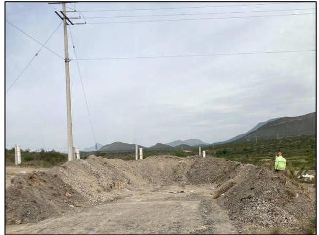
02. Se construyeron los bordos perimetrales de la celda temporal con apoyo de retroexcavadora.
