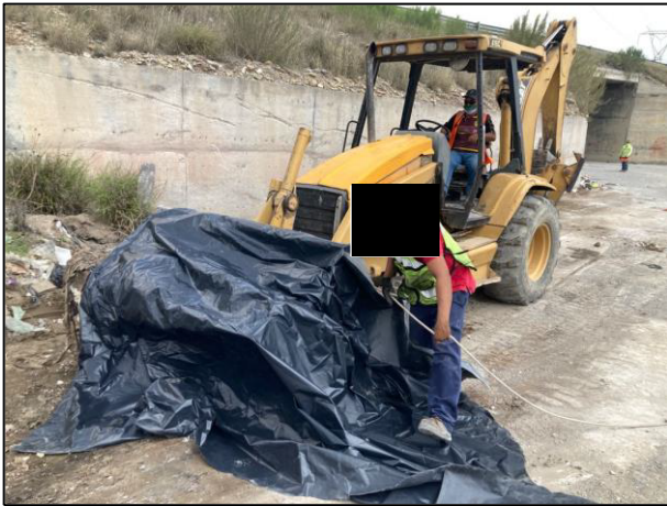
07. Durante el manejo del material contaminado (basura y escombros) este permaneció cubierto con membrana de polietileno de alta densidad.
