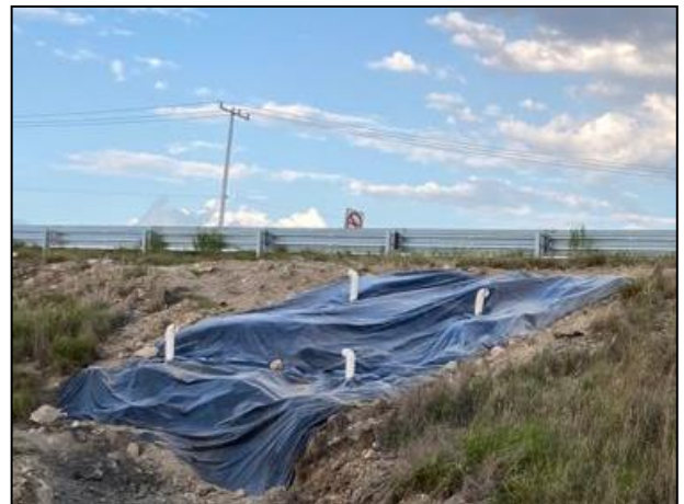
06. El Área Afectada fue cubierta en su totalidad con película de polietileno de alta densidad.
