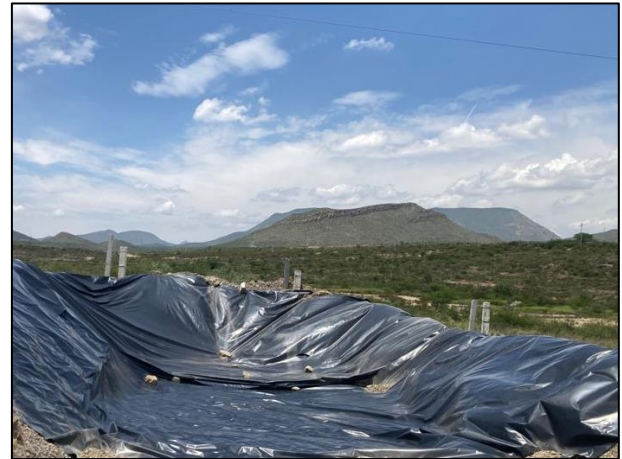
04. La celda provisional se cubrió con una película de polietileno de alta densidad.
