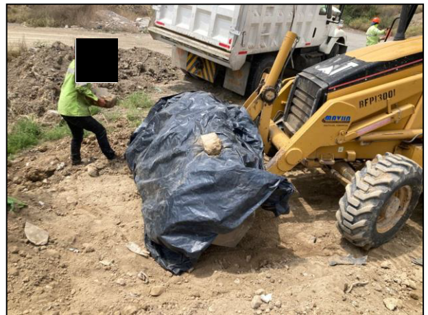
30. El material contaminado permaneció cubierto con membrana de polietileno de alta densidad durante su manejo.
