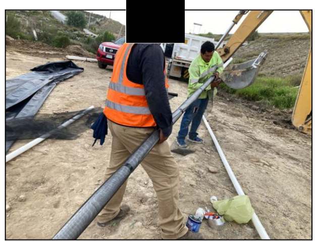
38. Ensamble de tubería PVC en la celda provisional.
