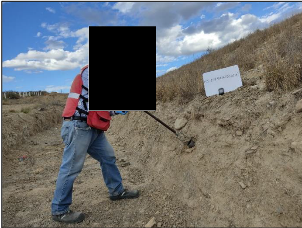
07. Se realizó la toma de muestras en las paredes de la Fosa de Excavación "A".
