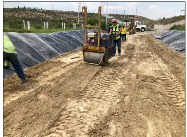
18. Con apoyo de una compactadora manual, se realizó la compactación de la segunda capa de arcilla.
