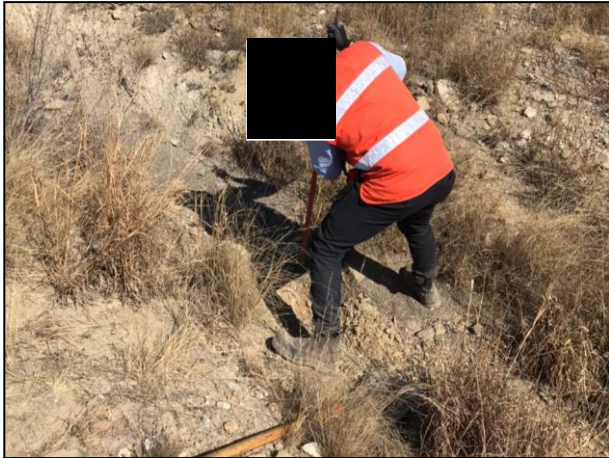
19. Con apoyo de barra metálica se realizó el ablandamiento del suelo.
