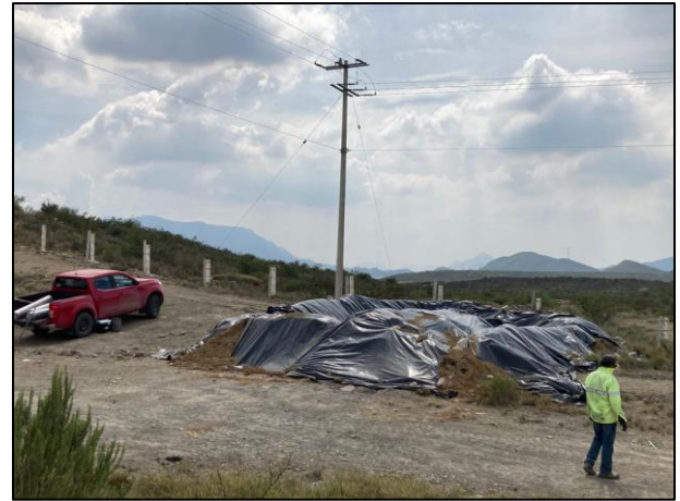
14. La celda temporal fue cubierta en su totalidad con membrana de polietileno de alta densidad. Vista general de la celda temporal.
