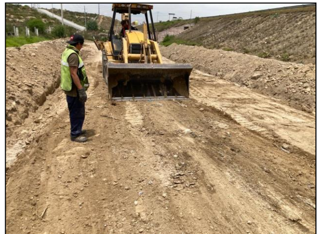
12. La arcilla fue esparcida en la base de la celda provisional con apoyo de retroexcavadora.
