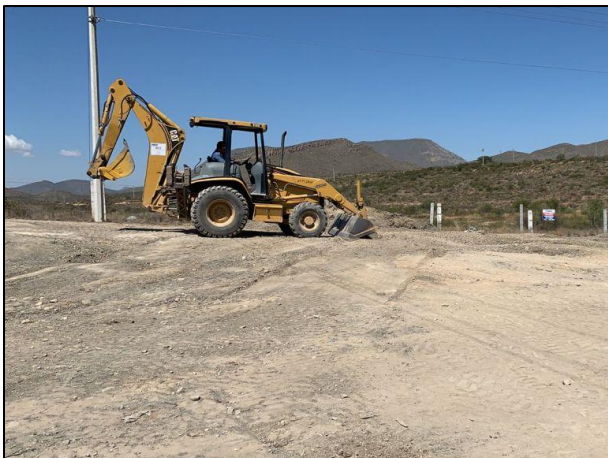
23. Con apoyo de maquinaria pesada se realizó la nivelación del sitio.
