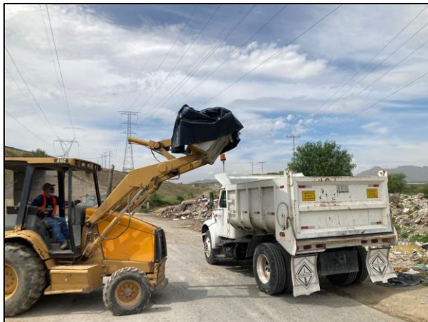
09. El material contaminado (basura y escombros) fue colocado en camión de volteo, para su posterior acarreo hacia la celda temporal.
