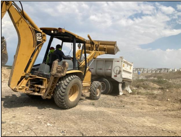
31. El material contaminado fue colocado en camión de volteo para su posterior acarreo y depósito en celda provisional.
