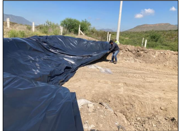
14. La base y bordos de la celda provisional se cubrieron con membrana de polietileno de alta densidad.
