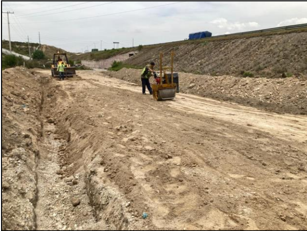
13. Con el uso de una compactadora, se realizó la compactación de la capa de arcilla colocada sobre la base de la celda provisional.
