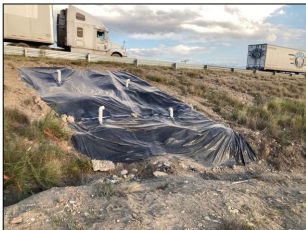
05. Área Afectada cubierta con película de polietileno de alta densidad y filtros de carbón activado.
