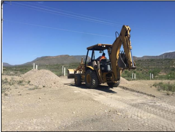
01. Se realizó el acondicionamiento del sitio para la construcción de la celda temporal.
