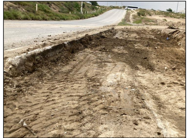
46. Vista general de la Fosa de Excavación “B”.
