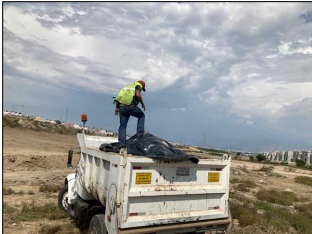
33. El material extraído fue cubierto con membrana de polietileno de alta densidad.
