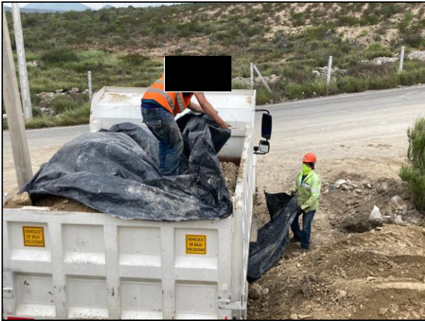
25. El material extraído fue cubierto con membrana de polietileno de alta densidad.
