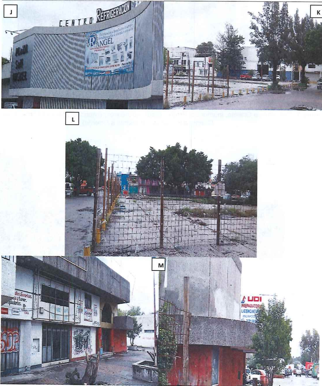
J: Locales comerciales colindantes con Calle Río Tecolutla (Vista de Sur a Norte). K: Calle río Tecolutla (Vista de Poniente a Oriente). L: Limite del predio con colindancia Suroriente (Vista de Suroriente a Sur poniente desde Calle Río Tecolutla). M: Locales comerciales y Escuela Preparatoria (Vista de Norte a Sur desde Calle Río Tecolutla y Calle Río Almería).
