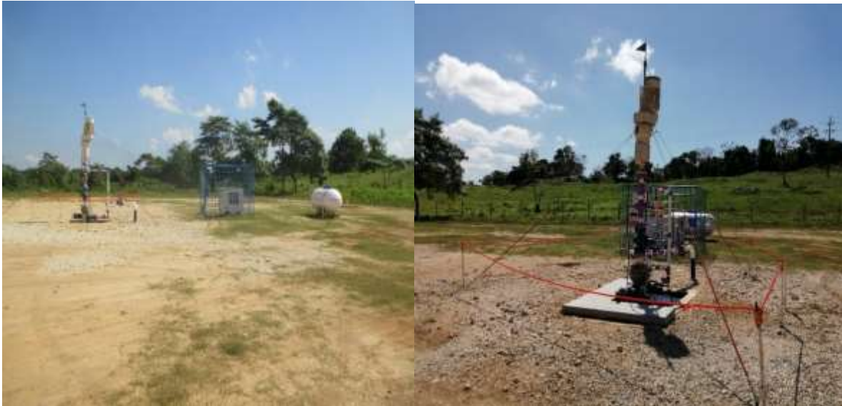
Figura V.1-22. Imagen representativa de boca de pozo BCP
