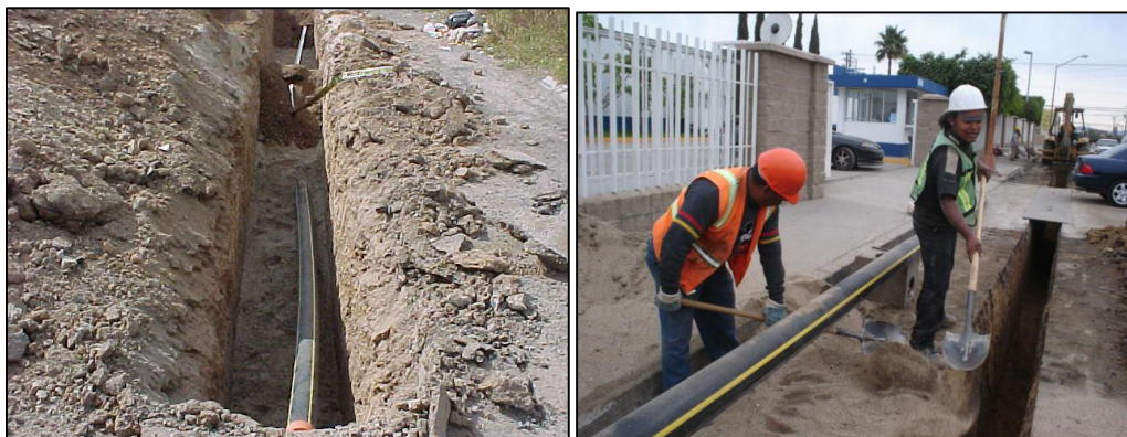
Figura X.90. Fotografía ilustrativa Preparación del fondo de Zanja y colocación de cama de arena Fuente: propiedad de Gas Natural Potosino
