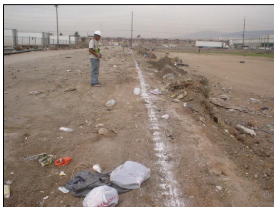
Figura X.71. Ejemplo de marcaje del trazo Fuente: fotografía propiedad de Gas Natural Potosino
