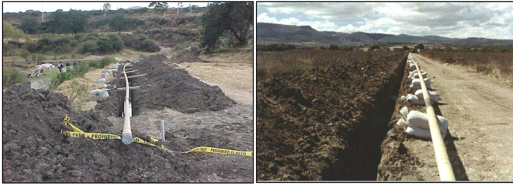
Figura X.88. Fotografía ilustrativa Alineado de Tubería Fuente: propiedad de Gas Natural Potosino
