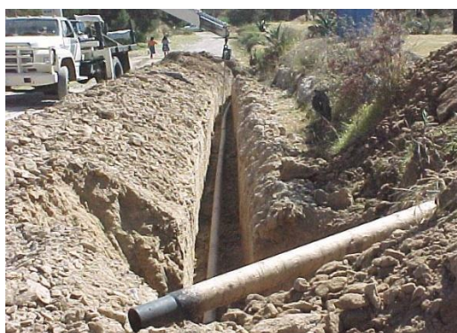
Figura X.91. Fotografía ilustrativa Bajado de tubería Fuente: propiedad de Gas Natural Potosino
