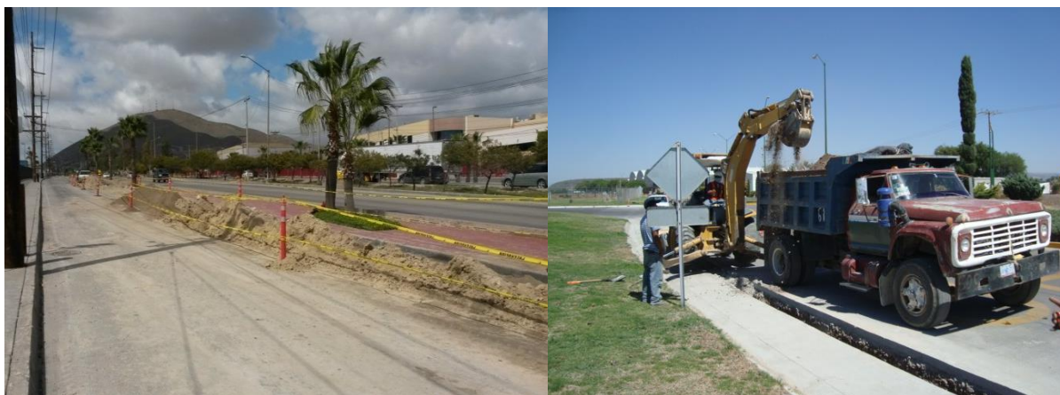
Figura X.84. Ejemplo de retiro de material de excavación
