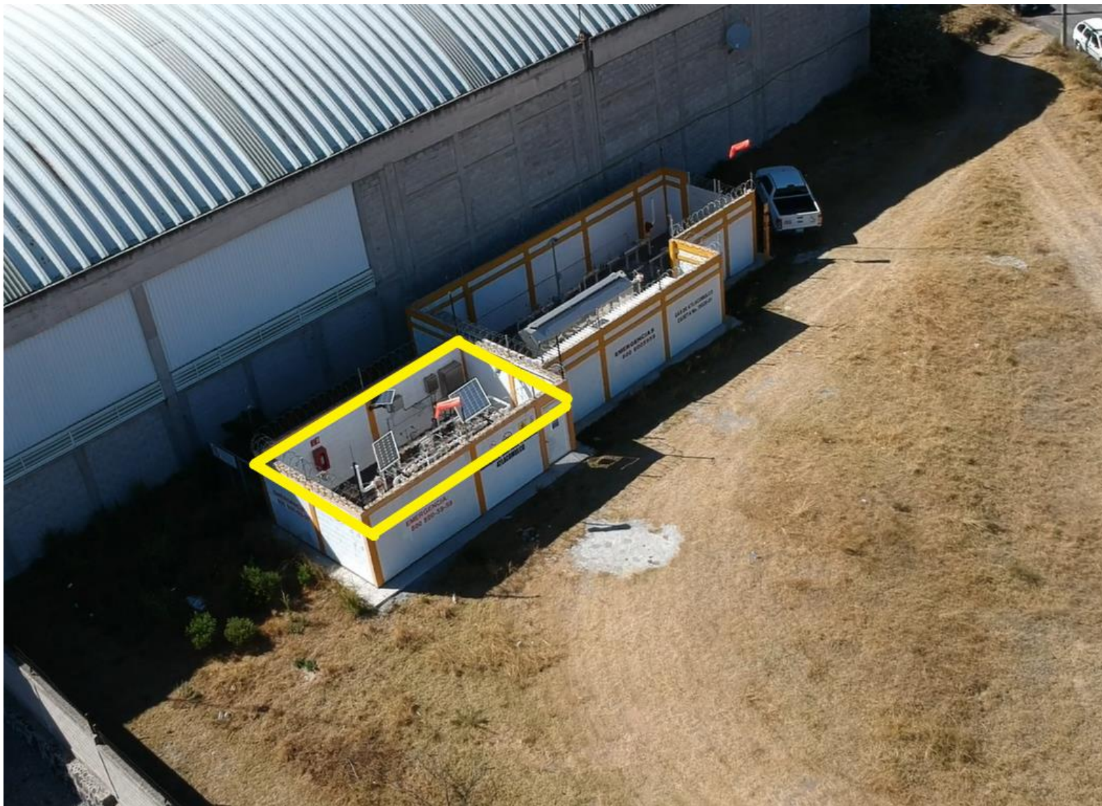
Figura X.04. Fotografía de la Estación de Medición y Regulación de Interconexión
