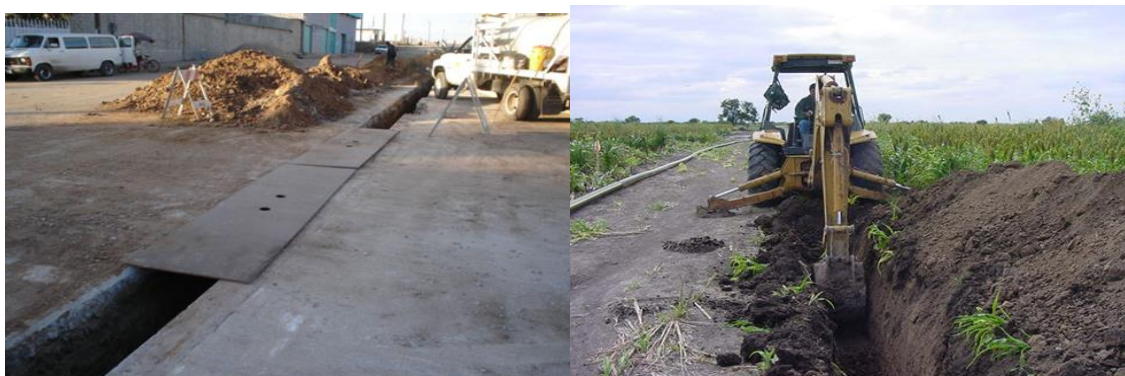
Figura X.83. Excavación de la zanja para el gasoducto e instalación de placas para paso
