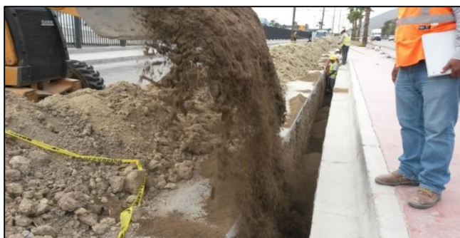
Figura X.92. Fotografía ilustrativa relleno Fuente: propiedad de Gas Natural Potosino
