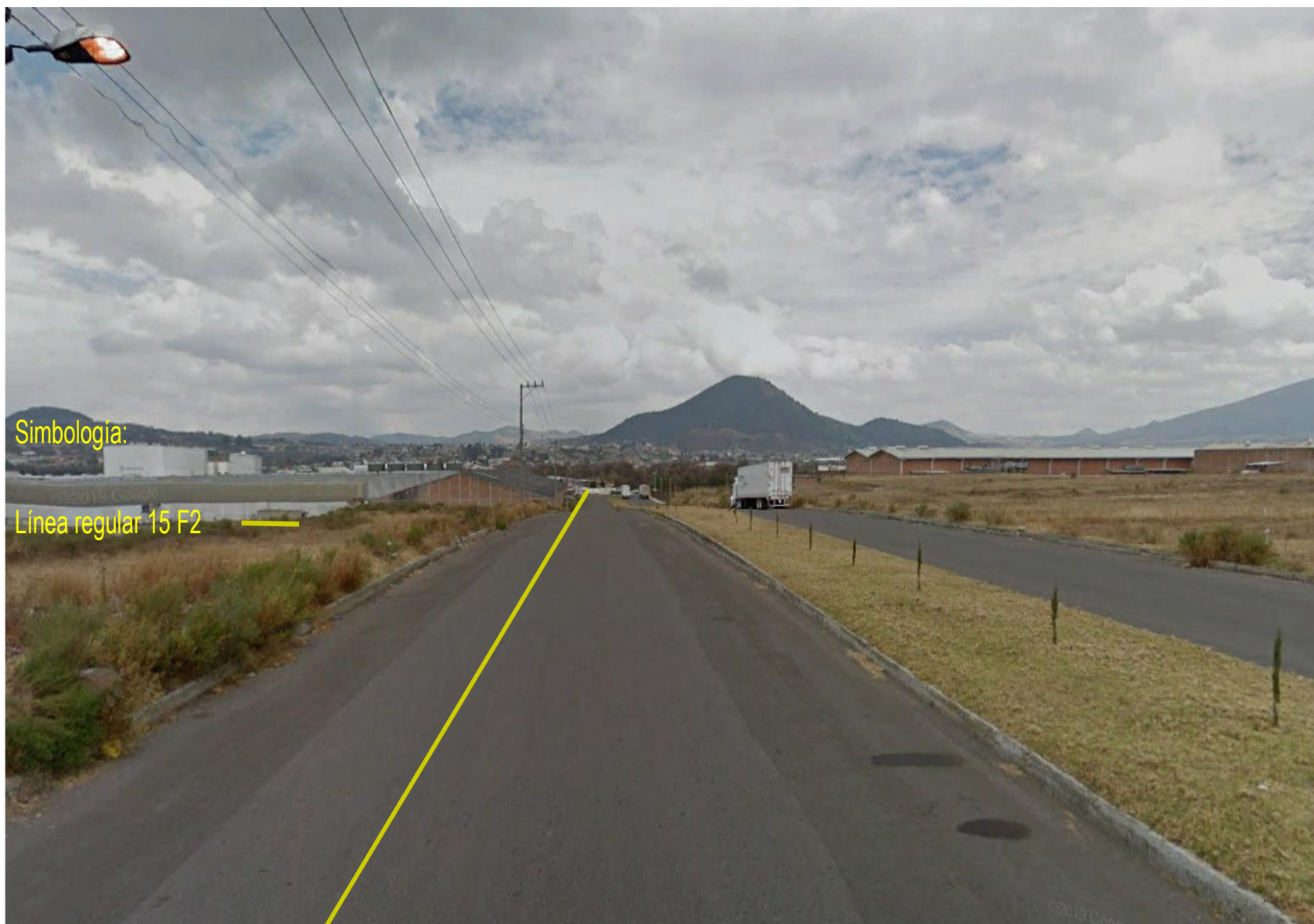
Figura X.45. Fotografía de la Línea Regular 15
