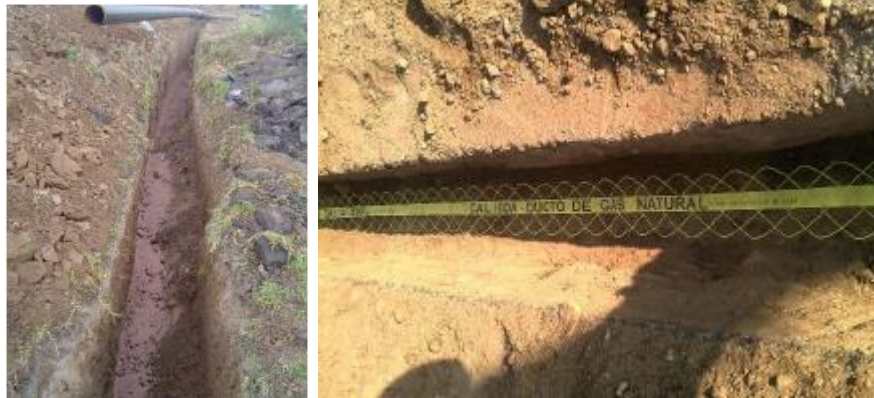
FIGURA 29. INSTALACIÓN DE TUBERÍA
