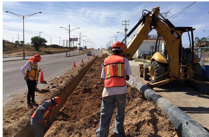
FIGURA 28. INSTALACIÓN DE TUBERÍA
