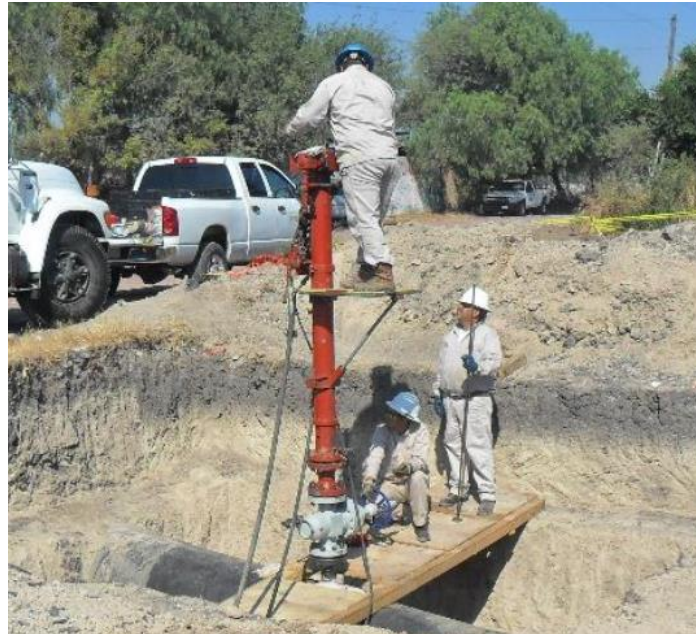
FIGURA 25. PUESTA EN MARCHA DE UN HOT TAPPING, EJEMPLO.
