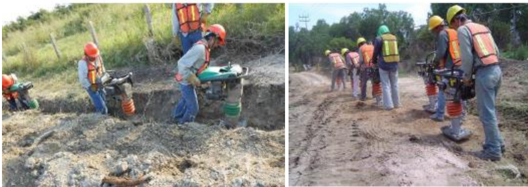
FIGURA 30. RELLENO Y COMPACTACIÓN
