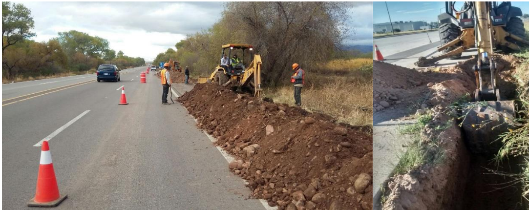
FIGURA 26. APERTURA DE ZANJA, EJEMPLO.
