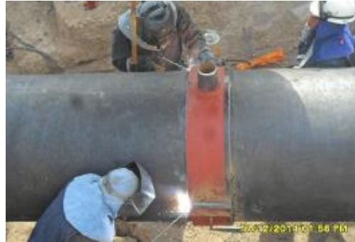
FIGURA 23. COLOCACIÓN DE LA ENVOLVENTE COMPLETA, EJEMPLO.
