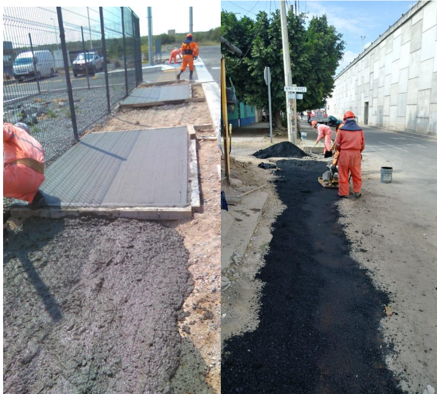
FIGURA 36. REPOSICIÓN DE PAVIMENTO O BANQUETAS
