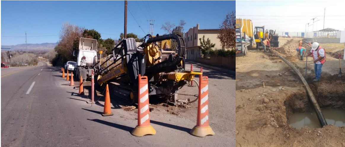
FIGURA 34. PERFORACIÓN DIRECCIONAL
