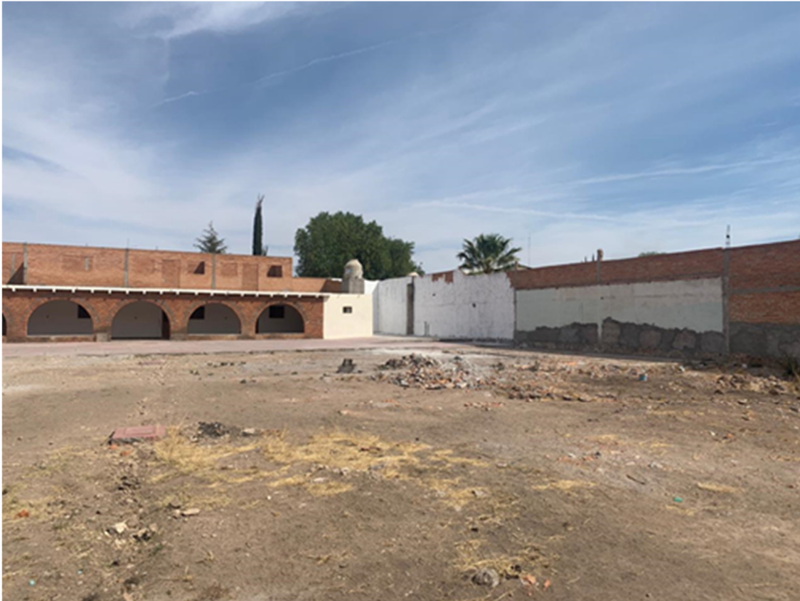
Figura II. 10. Construcciones en el predio.
