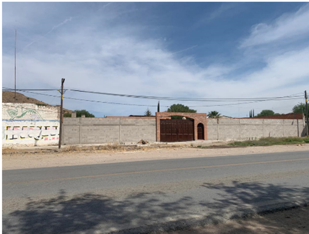
Figura I. 5. Vista del sitio del proyecto a pie de Libramiento Villa de Reyes-San Luis Potosí.
