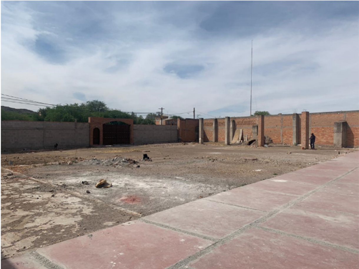
Figura II. 11. Estructuras en el sitio del predio.
