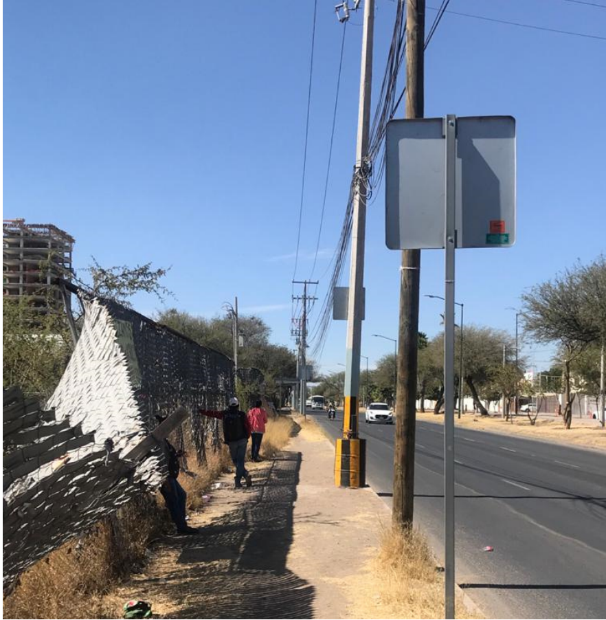
Ilustración 23.- Líneas eléctrica y telefónica aéreas, al noreste del predio, sobre Blvd. Vicente Valtierra.
