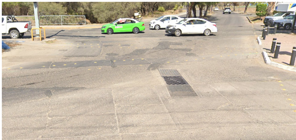
Ilustración 24.- Red municipal de drenaje ubicada al noreste del predio, sobre Blvd. Vicente Valtierra.
