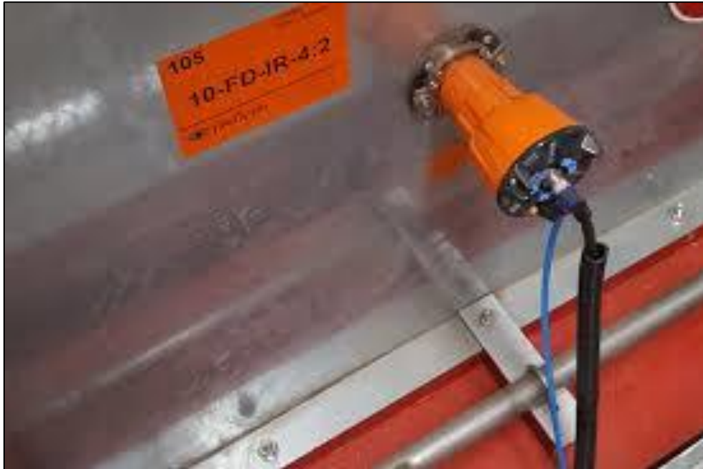
Imagen ilustrativa del Detector del Sistema de Detección de Incendios.
