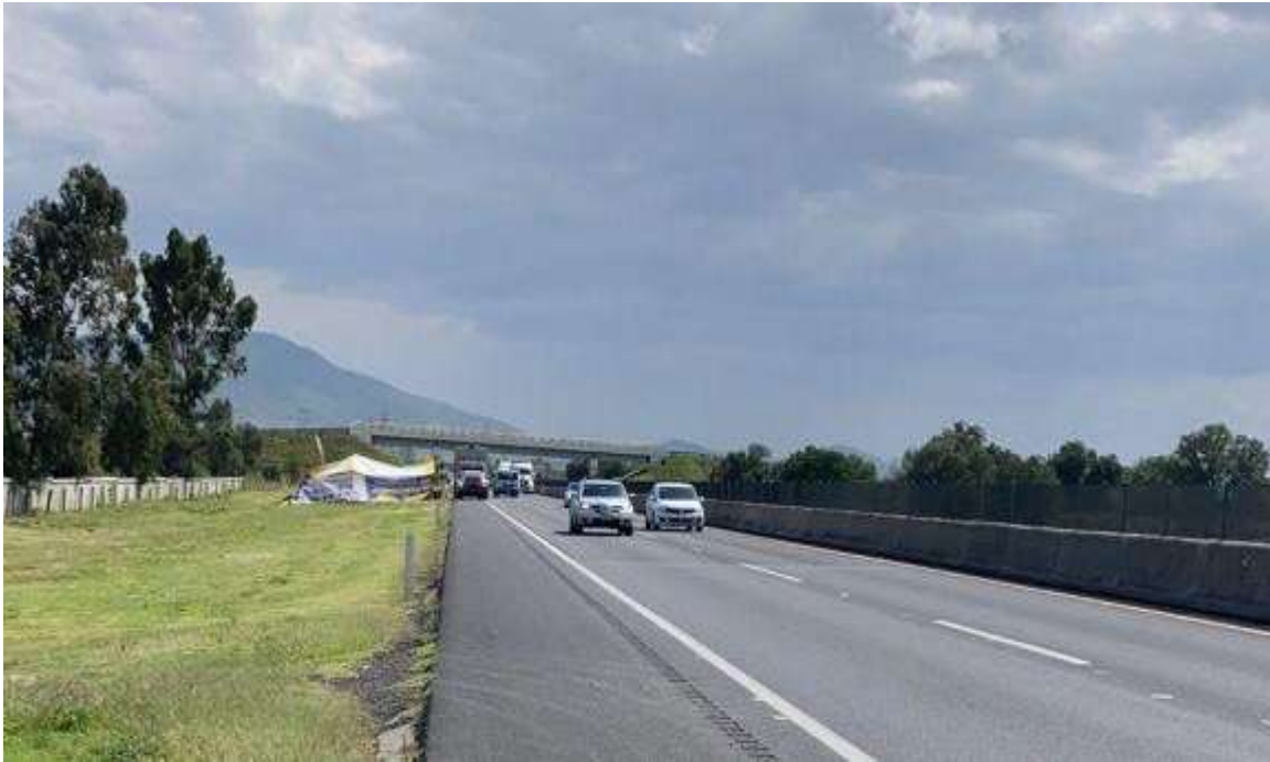
Fig. 7 Carr. Ecatepec- Tulancingo limite oeste del predio, del proyecto.
