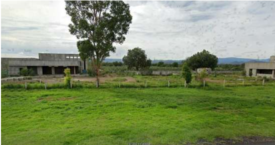
Fig. 25 Vista actual del predio que se utilizará para el proyecto, donde se aprecian construcciones realizadas en el año 2014. Cuando se iba a construir el proyecto.
