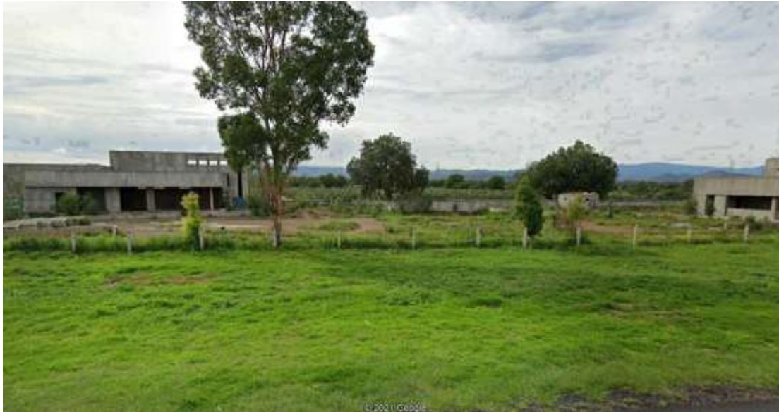
Fig. 6 Vista actual del predio que se utilizará para el proyecto, donde se aprecian construcciones realizadas en el año 2014. Cuando se iba a construir el proyecto.
