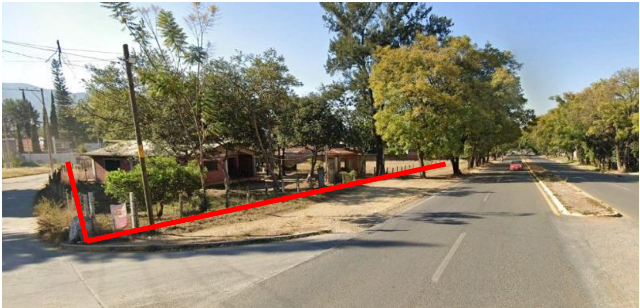
Fotografías 2.- Dentro del predio existe una casa habitación que será demolida.
