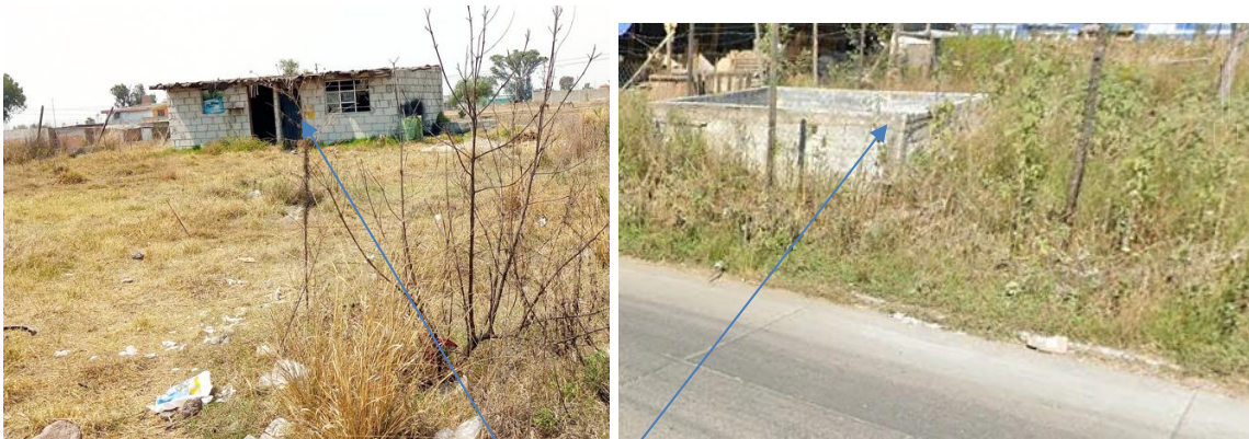
Muros que se van a demoler
