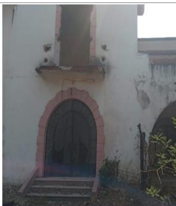
Vista del centro del predio a la colindancia noreste
