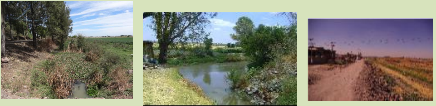
IMAGEN 10 Esgurrimientos no controlados Dren 20, estructura de cruce de FFCC, El Tajo 6,7, Canal Sardinas PTE., Fuente: Fotografías del Ayuntamiento Municipal puntos de riesgo.
