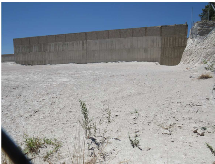
Fotografía 1: Interior del predio.
