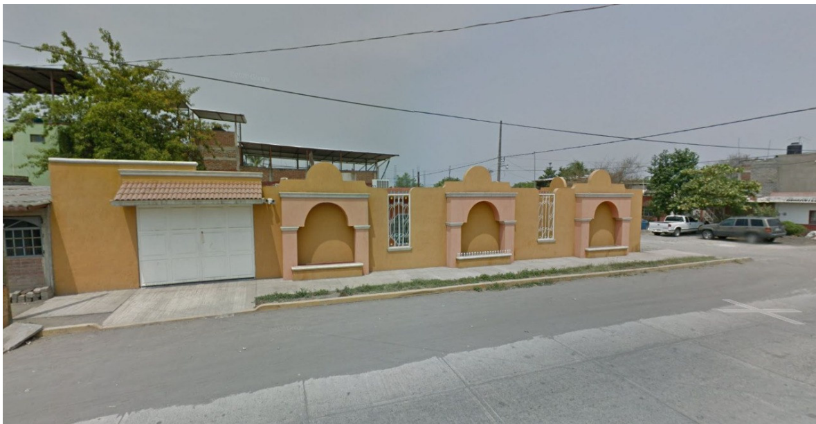
Imagen 5.6.-Vista desde la calle Leandro Valle.
