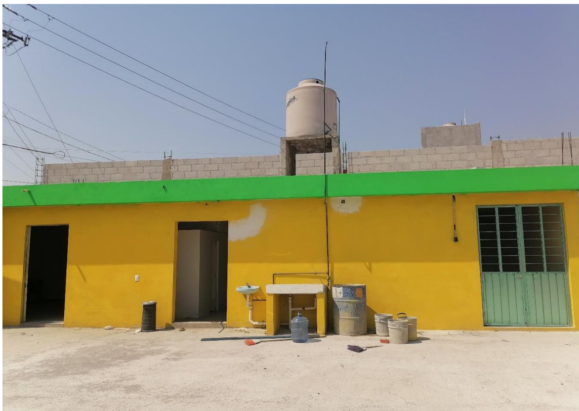
OFICINA Y BAÑOS UBICADOS EN EL LADO SURESTE
