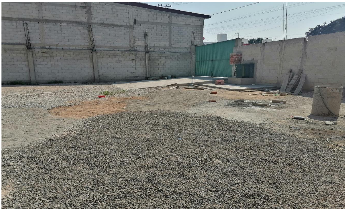
ACCESO NORESTE DEL SITIO DEL PROYECTO
