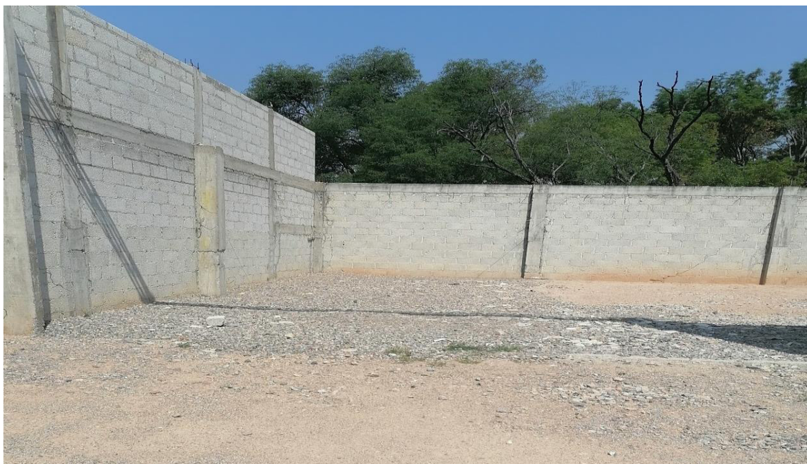
ESQUINA SUROESTE DEL SITIO DEL PROYECTO
