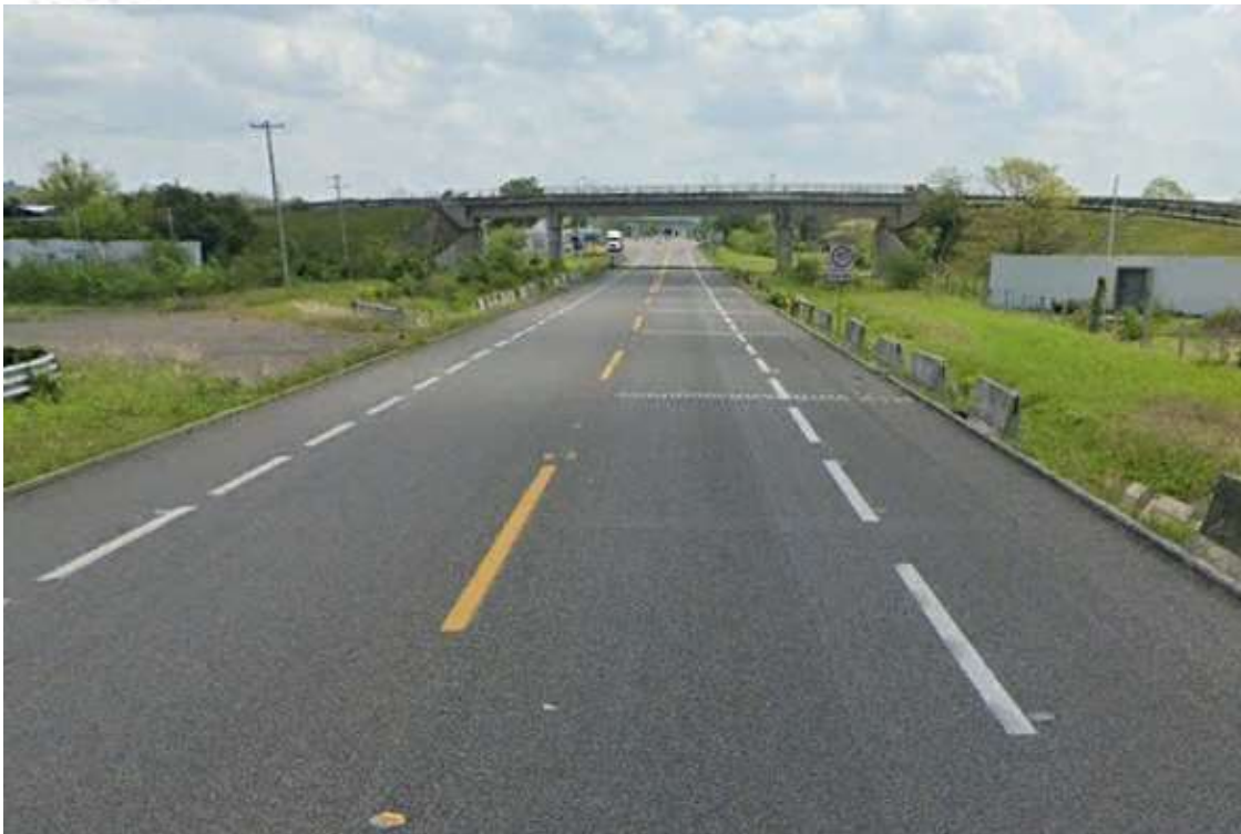
Fotografía No. 3. La Estación de servicio se ubica en la carretera México-Tuxpan, en el caso de TRADE OV (2) se encuentra en dirección a Tuxpan, Veracruz.
