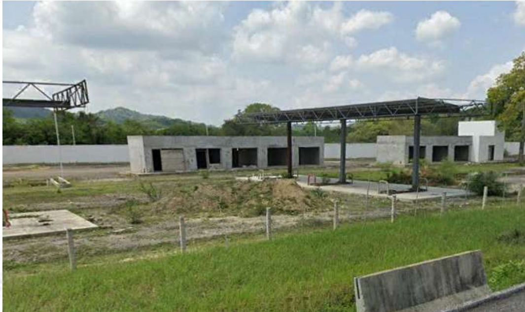
Fotografía No. 2. En la imagen se observa parte de la superficie del proyecto para el Termino de construcción, operación y mantenimiento de la Estación de Servicio: "TRADE OV, S.A. DE C.V. (2)", se van a realizar trabajos de obra de deshierbe y limpieza del terreno.
