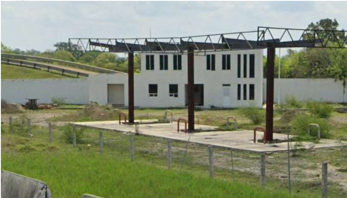
Fotografía No. 1. Dentro de la superficie que cuenta con autorización para obras iniciales de acuerdo al oficio ASEA/UGSIVC/DGGC/11458/2017 se observa el edificio administrativo terminado debido a que cuenta con aplanado y pintura, así como las ventanas terminadas.
