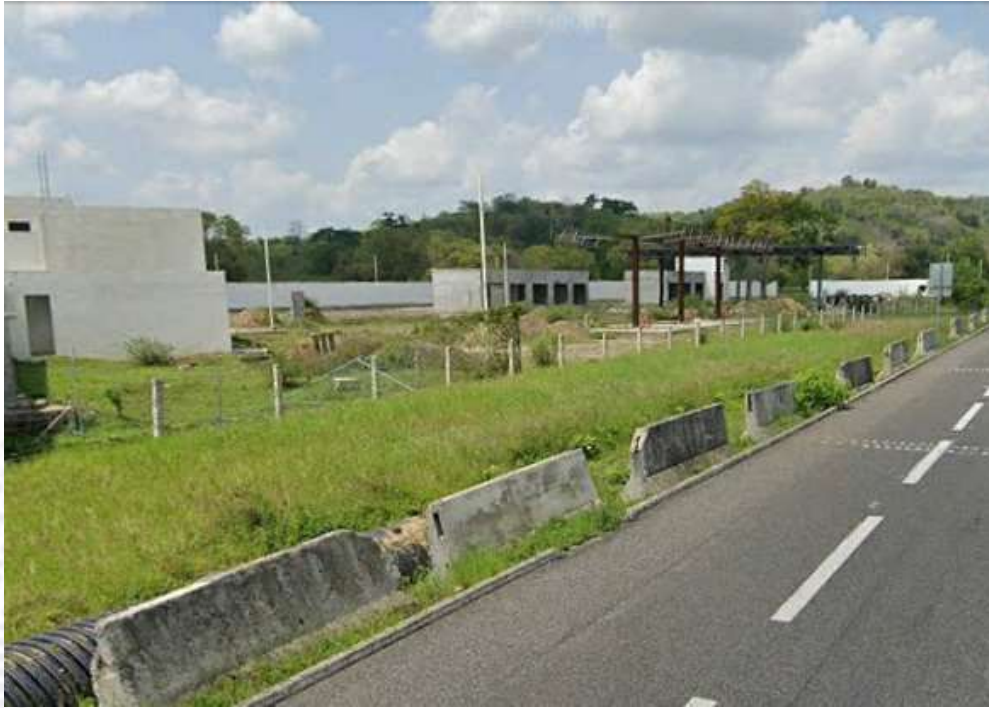
Fotografía No. 4. Lo que se pretende con el proyecto de Termino de construcción, operación y mantenimiento de la Estación de Servicio: "TRADE OV, S.A. DE C.V. (2)" es concluir la obra para la operación y mantenimiento donde se contempla colocar el asfalto.
