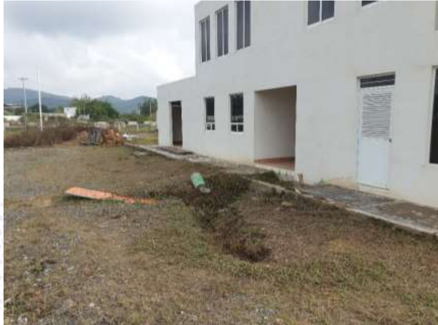
Fotografía No. 6. Las actividades que contempla el proyecto pretende actividades de trazo y nivelación para colocar la capa de asfalto para las áreas inconclusas de la Estación de servicio.
