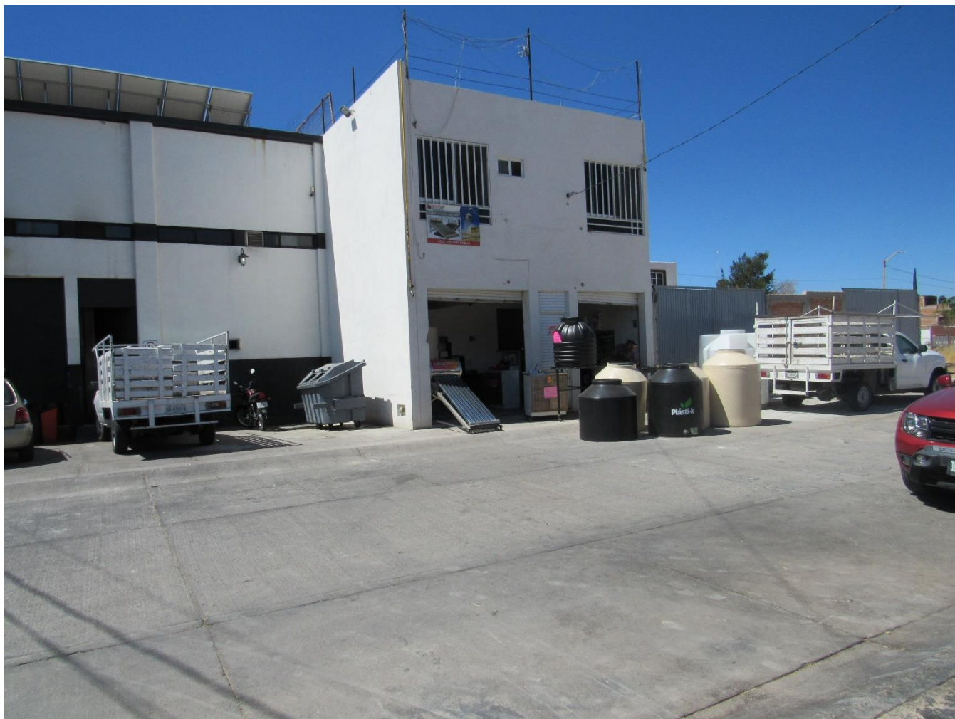
El predio colinda con una ferretería en una zona de urbanización.
