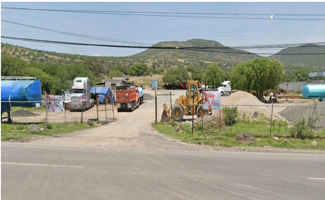
IMAGEN 2. Vista del predio del proyecto de la estación de carburación(EST).
