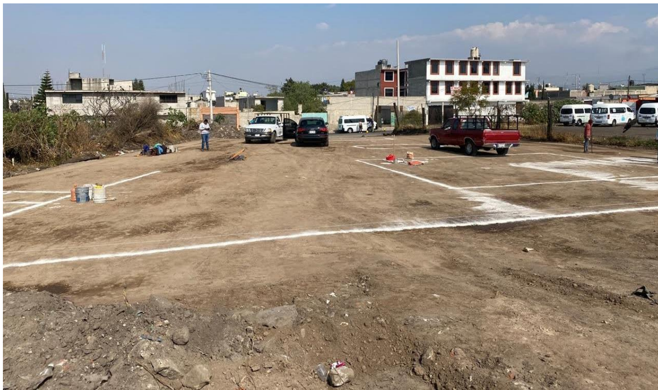
Ilustración 18. Otra vista general del predio
