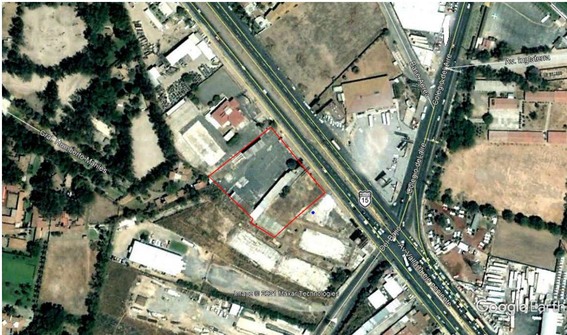
Imagen 12. Vista del lado poniente del predio, sobre el Libramiento oriente
