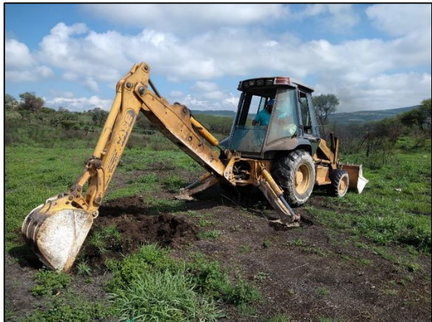
01 - Con apoyo de retroexcavadora se empezaron las labores en el sitio.
