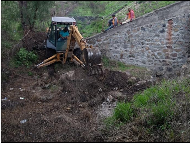
07 - Acondicionamiento del terreno para la construcción de la barrera de contención en la Zona afectada B.
