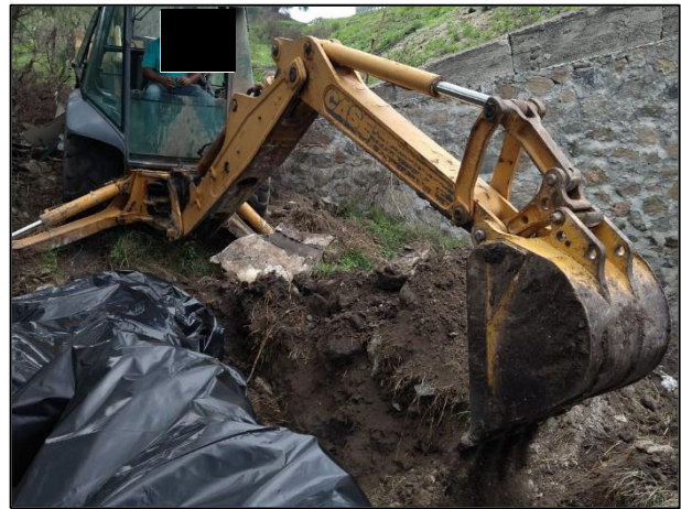
10 - Con apoyo de la retroexcavadora se rellenaron las zanjas con material edáfico libre de contaminantes.
