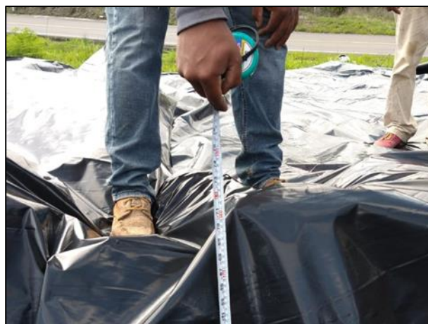
04 - Con apoyo de flexómetro se tomó la medida de la profundidad de las zanjas.
