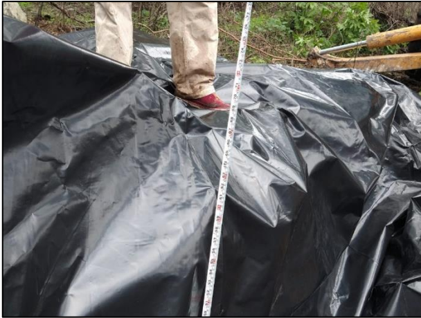
09 - Con apoyo de flexómetro se tomó la medida de la profundidad de las zanjas.
