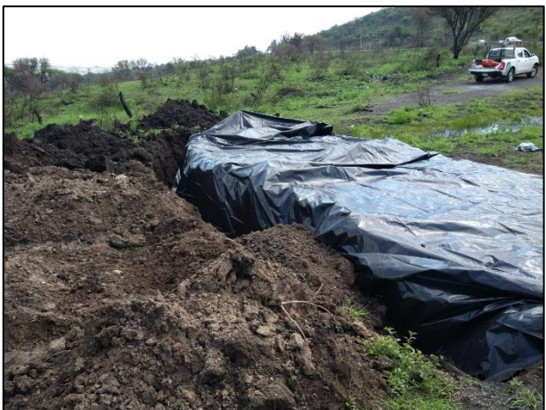
03 - Dichas barreras de contención (bordos y zanjas) fueron cubiertas con película de polietileno de alta densidad, esto con apoyo de recurso humano.
