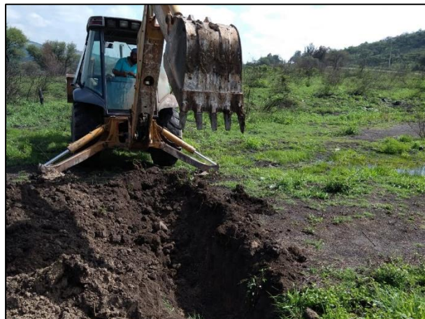
02 - Construcción de una zanja, así como de un bordo perimetral, ambos ubicados en los costados de cada Zona afectada (A y B) en donde el sitio presenta una inclinación significativa del terreno.
