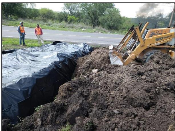
05 - Con apoyo de la retroexcavadora se rellenaron las zanjas con material edáfico libre de contaminantes.
