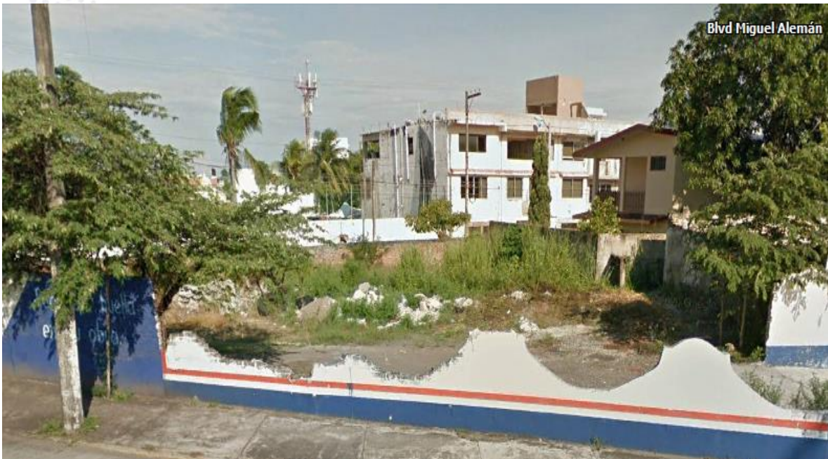
Fotografía No. 5. En la imagen se observa la vista frontal del predio con la barda que se pretende sea demolida con las actividades de preparación del sitio, así como las hierbas, pastos y las especies conocidas como capulín blanco que serán removidas.
