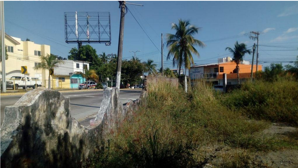
Fotografía No. 3. Vista dentro del predio de proyecto hacia el Boulevard Miguel Alemán, donde se observa parte de la barda que existe actualmente y que dentro de las actividades de preparación del sitio será demolida.
