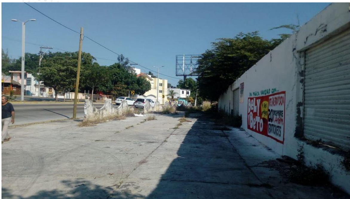
Fotografía No. 1. Vista exterior del predio del proyecto para preparación del sitio, construcción, operación y mantenimiento de la Estación de Servicio denominada SERVICIO ENXEBRE S.A. DE C.V. ubicada en Boulevard Miguel Alemán esquina calle Revolución Número 3576 de la Colonia Centro, Boca del Río, Veracruz.
