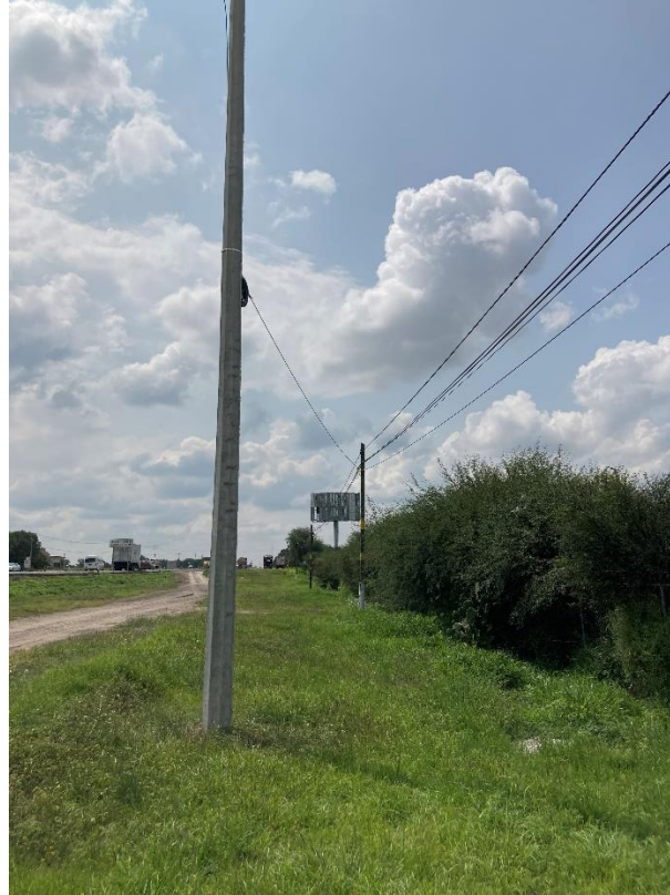
Ilustración 20.- Líneas eléctrica y telefónica aéreas, al suroeste del predio, sobre carr. Qro-SLP
