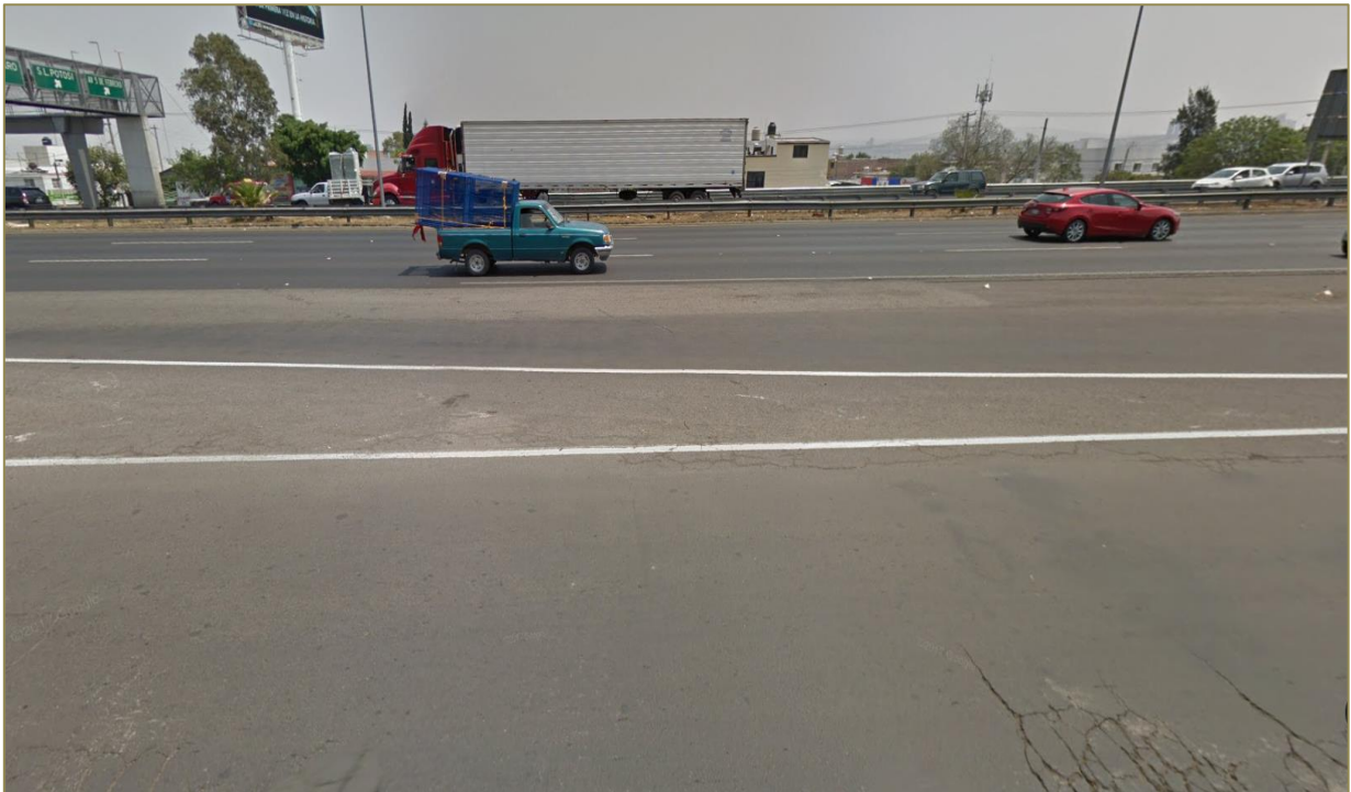
Foto III.1.a)-6. Vista desde la Avenida 2 y lateral de la Carretera Federal Número 57, de Sur a Norte en donde se aprecian los cuerpos de la vialidad.
