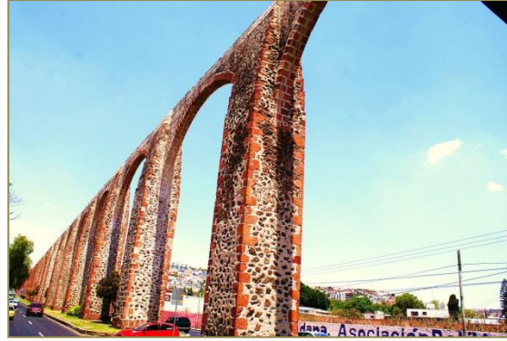
Acueducto de Querétaro
