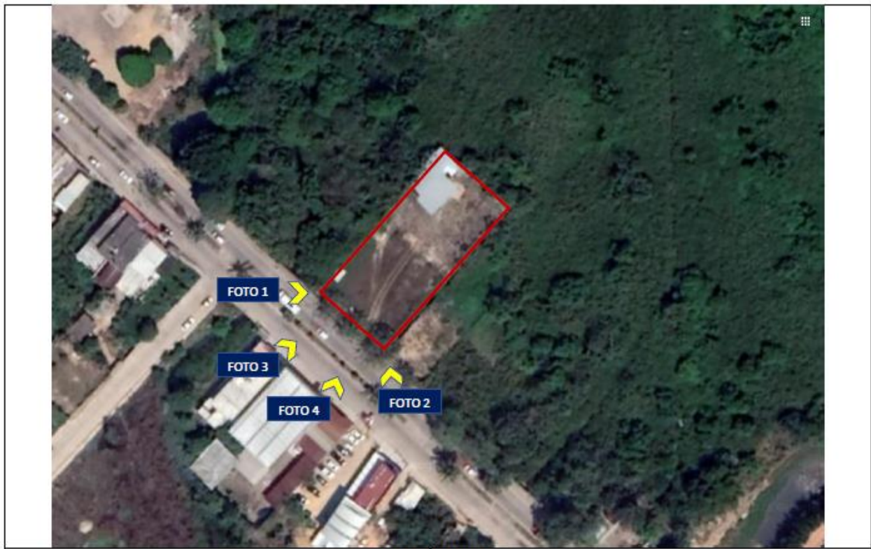
Imagen 1. Polígono para la construcción de la estación de servicio Fuente: elaboración propia con datos del levantamiento topográfico
