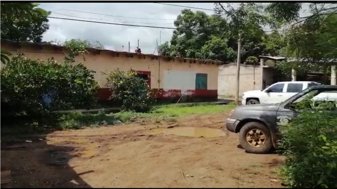
Vista frontal de las edificaciones desocupadas.
