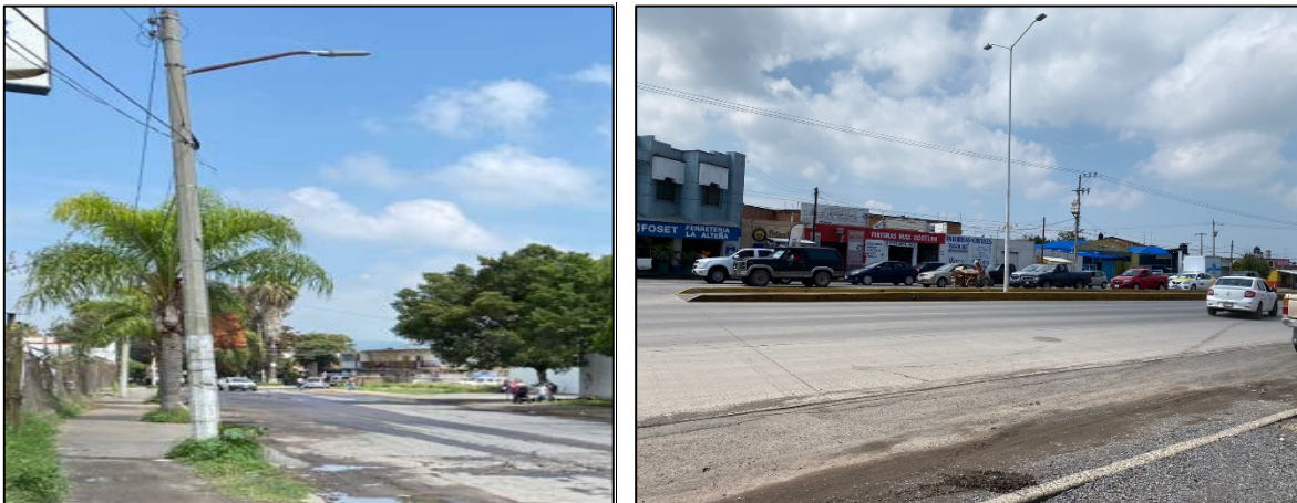
Foto 13.- Postes de iluminación por Calle Cecilio Carrillo Y Av. Francisco Zarco.
