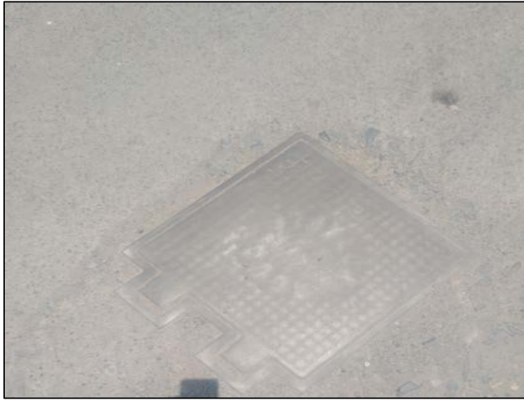
Foto 14.- Línea de agua potable ubicado en Av. Francisco Zarco.
