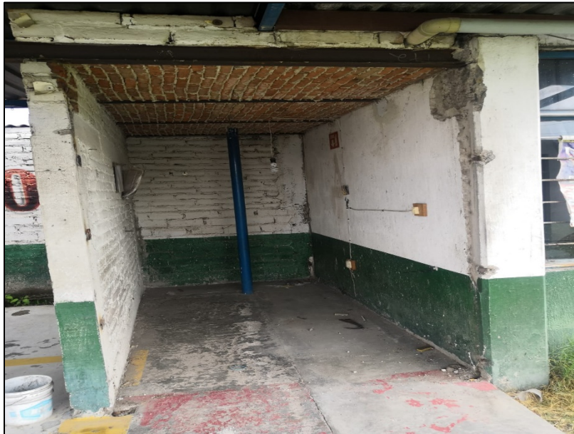
Foto 9.- Obras civiles dentro del predio
