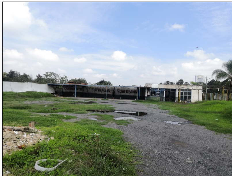
Foto 8.- Infraestructura que se encuentra dentro del predio.
