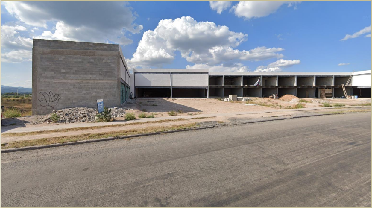
Foto III.1.a)-6. Vista desde la Vista desde la Avenida Paseo de La Estancia hacía la colindancia Suereste, en donde se observa un predio en construcción y el cuerpo de la vialidad.
