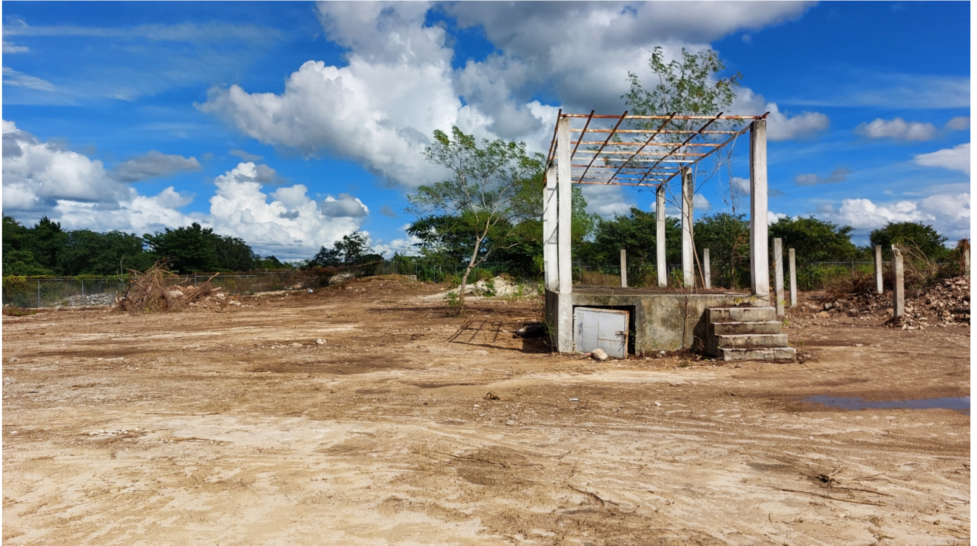
Ilustración 13 Imagen del predio, donde se observa una plataforma abandonada que era utilizada para almacenar materiales
