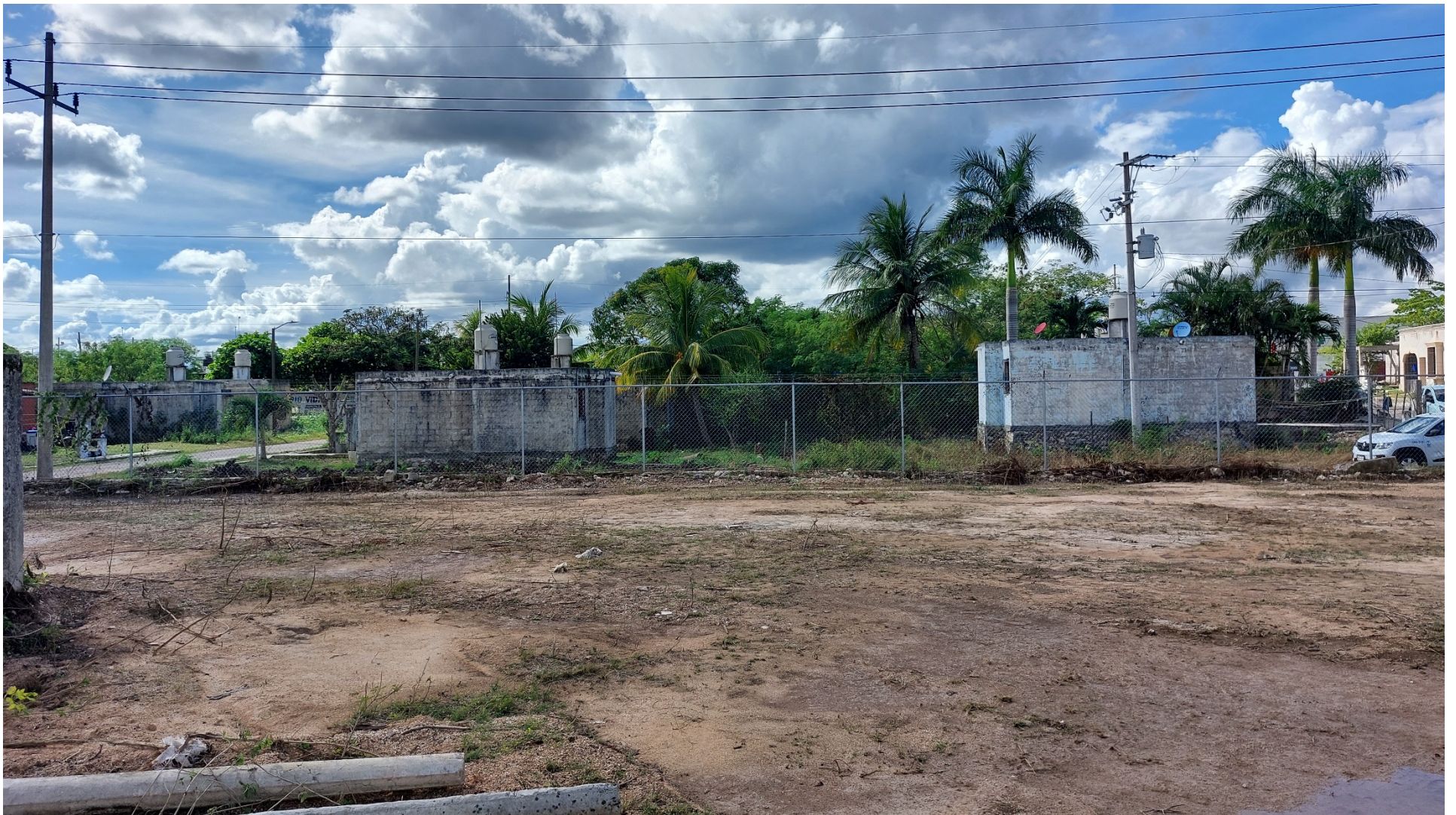
Ilustración 18 Se observa la colindancia frontal del predio del proyecto donde se encuentran casas habitación posterior a la Calle 24-A
