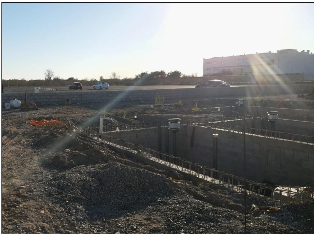
Fotografía 4. Vista actual del avance en la ejecución del proyecto en zona de almacenamiento.
