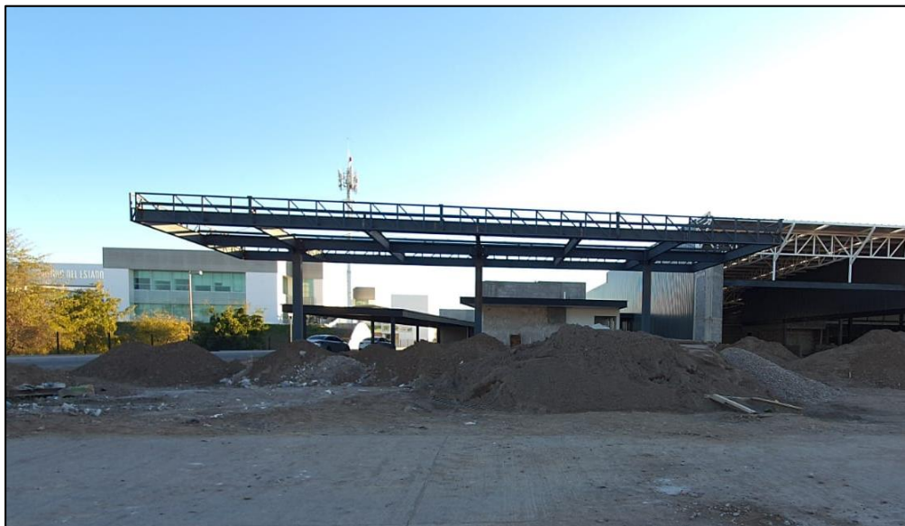
Fotografía 2. Avances de obra en la zona de despacho.
