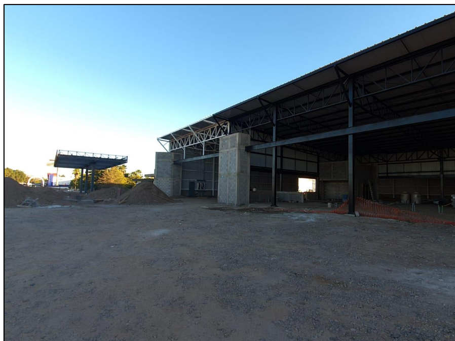
Fotografía 6. Avance de obra complementaria al proyecto
