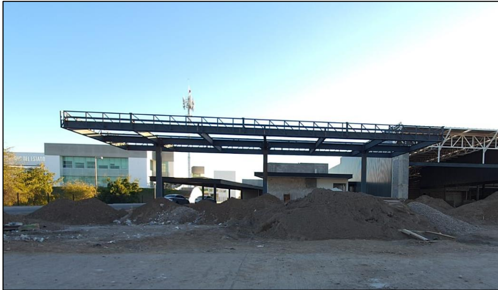
Fotografía 1. Vista actual de los avances de obra en la zona de despacho.
