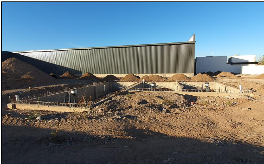
Fotografía 3. Avance de obra en zona de almacenamiento.
