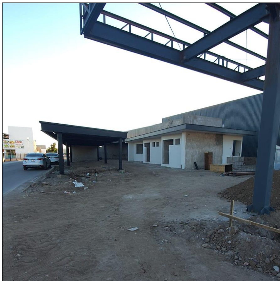
Fotografía 5. Avance actual de obra del proyecto.
