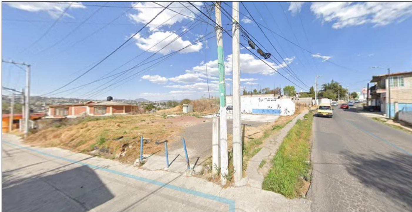
Ilustración 14. Colindancia con casa habitación y terreno baldío.
