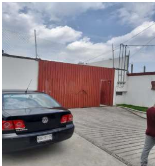
VISTA DEL ACCESO A LA ESTACIÓN DE SERVICIO DE GAS L.P. PARA CARBURACIÓN.
