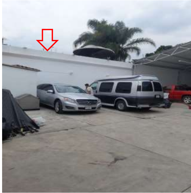
Parte norte del predio se encuentra la barda perimetral.
