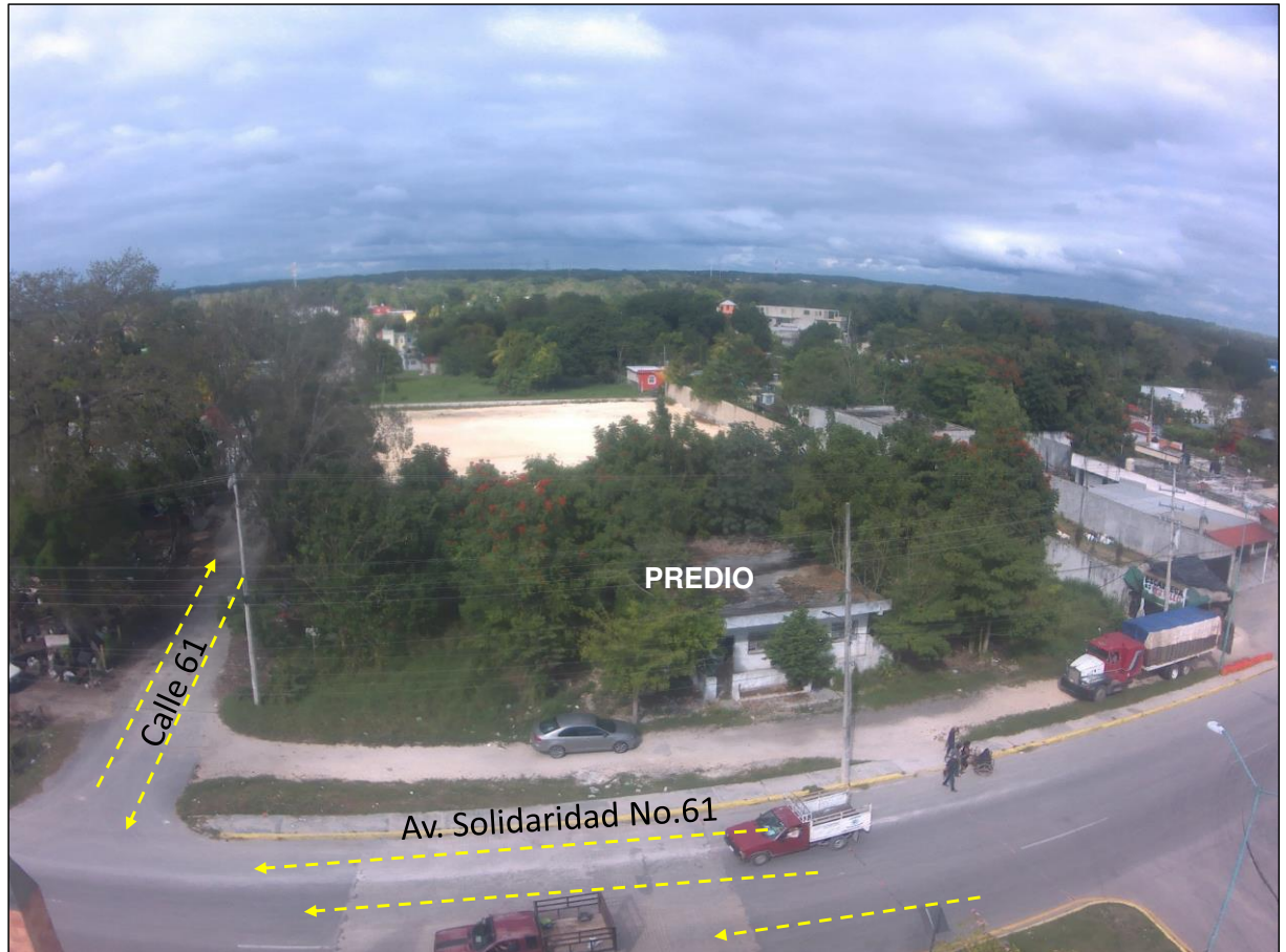
Figura III. 17.- Vista de la vía de acceso principal y secundaria al predio.
