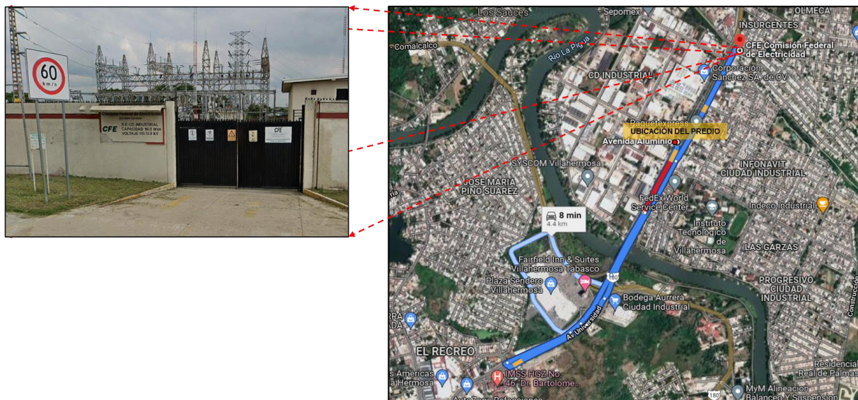
Figura III.4.- Ubicación de la CFE Subestación Eléctrica Cd. Industrial.
