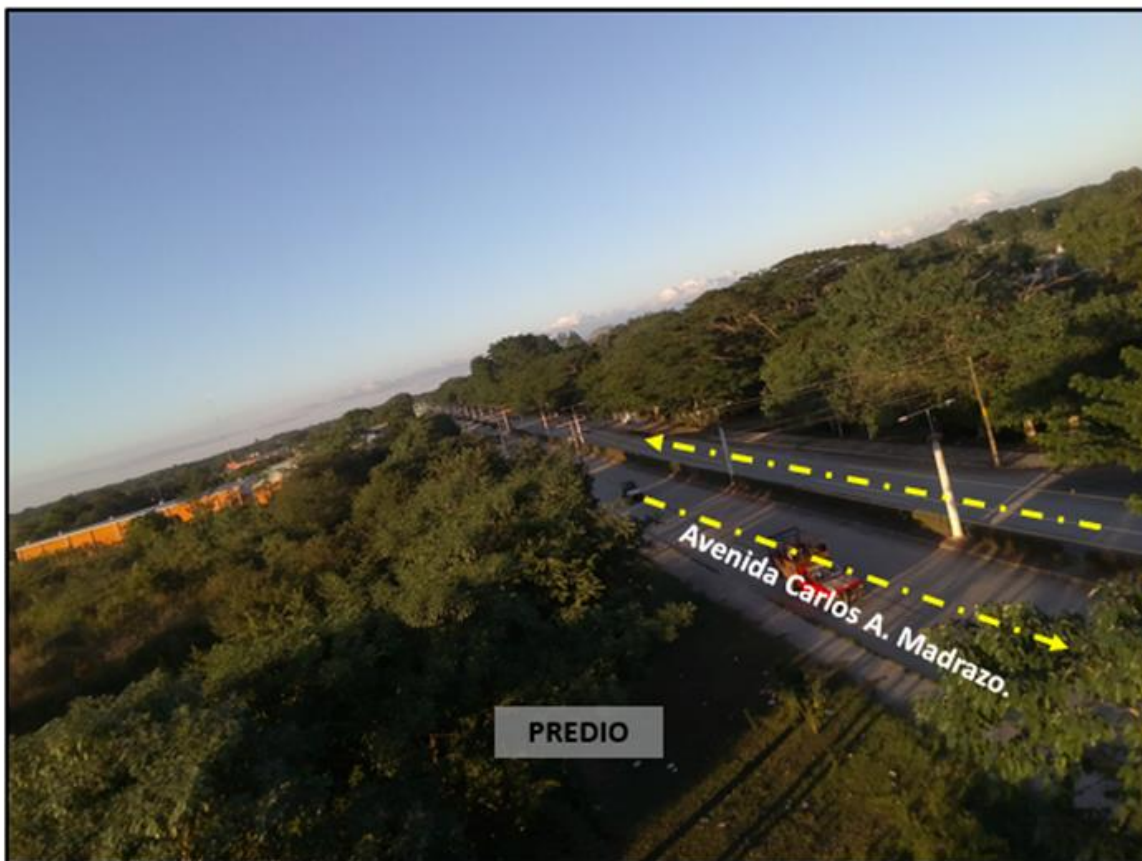
Figura III. 216.- Vista de la vía de acceso principal al predio.
