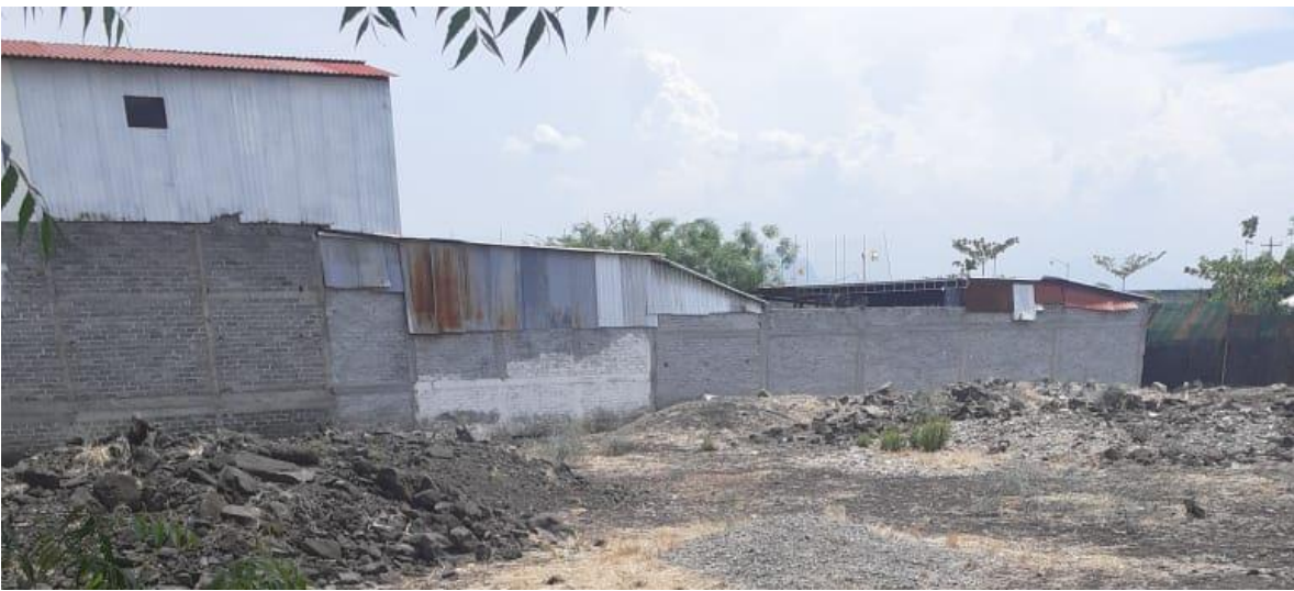
Figura 24. Vista hacia el Sureste del predio
