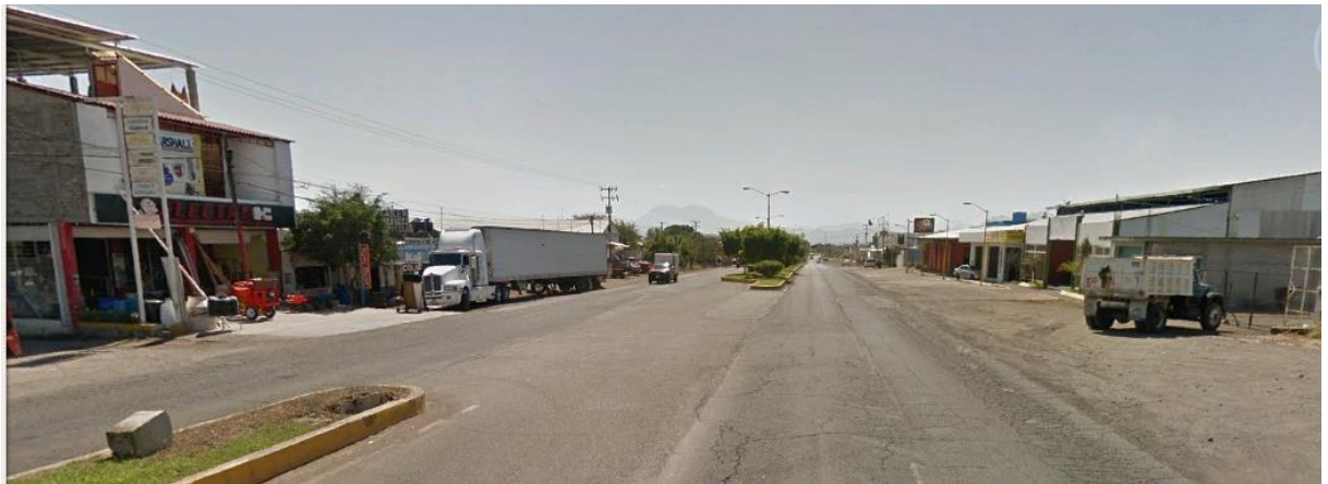
Figura 12.1. Vista hacia el hacia el Sur del proyecto
