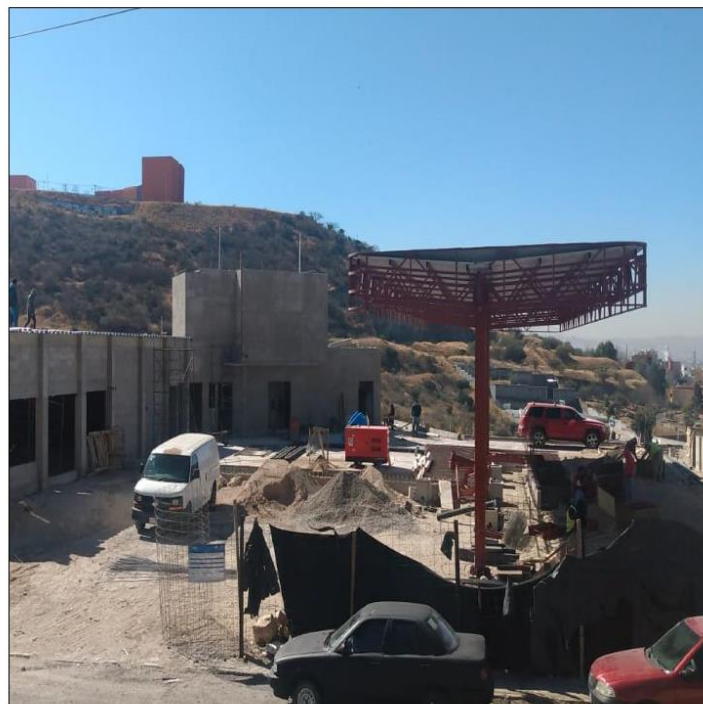
PUNTO NORTE CON VISTA AL CENTRO DEL PROYECTO X:355456.50 m E Y: 2281549.57 m N
