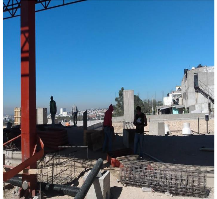
PUNTO MEDIO DEL PROYECTO CON VISTA AL OESTE X:355455.00 m E Y: 2281504.00 m N
